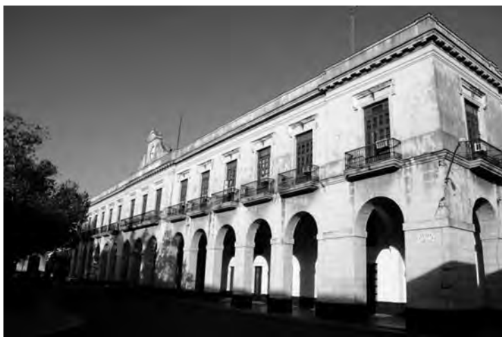
Figura 22: Palacio de Gobierno y Ayuntamiento (1851-1855) del ingeniero español Antonio de Montenegro, ejecutor el maestro de obras José Carbó. Fuente: Fotografía de Julio Larramendi.
