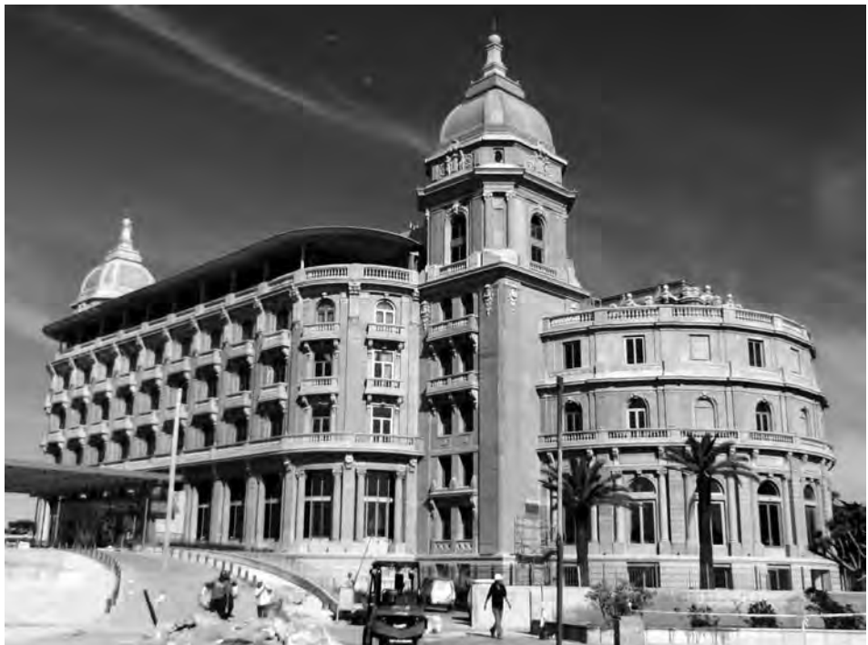
Figura 4: Hotel Casino Carrasco. Se observa el piso superior añadido al cuerpo central, reciclaje, 2012. Fotografía de la autora.
