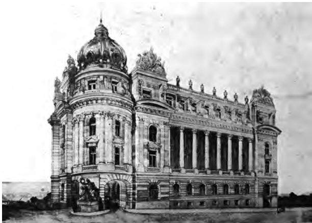
Figura 24: Proyecto para la Biblioteca del Consejo Nacional de Mujeres. Juncal y Basavilbaso. Ciudad de Buenos Aires. Fuente: Anuario de Arquitectura e Ingeniería de la República Argentina, 1922, pp. 98-100.
