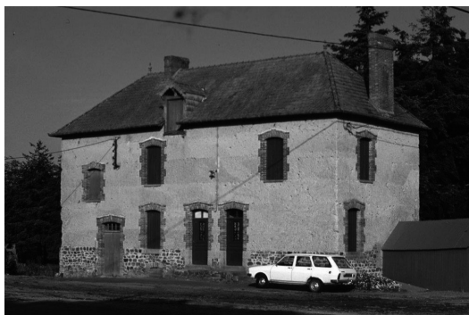
Figura 2: Vivienda de bauge en la periferia de la ciudad de Rennes. Fuente: (Joffroy, 1991. Archivo CRAterre).
