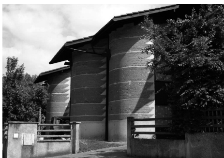
Figura 7: El Domaine de la terre en 2017: edificio construido por el arquitecto Berlotier. Fuente: (Joffroy, 2017. Archivo CRAterre).
