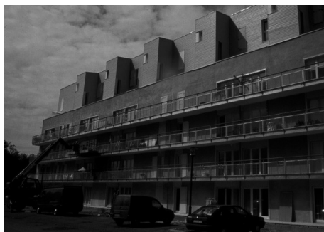
Figura 10: Edificio Salvatierra en Rennes, del arquitecto Barrie, conformado por 43 viviendas y cuya fachada sur es de tapial prefabricado. Fuente: (Archivo CRAterre, 2003).
