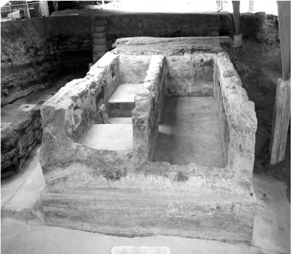
Figura 10: En Joya de Cerén, El Salvador, se usó tierra modelada y compactada en algunos muros de carga y refuerzos de componentes de bajareque. Sin embargo, la aldea sucumbió bajo cenizas volcánicas. Fuente: Fotografía del autor.
