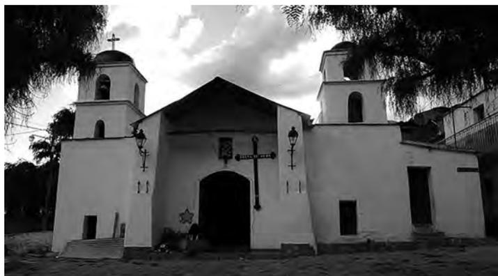
Figura 8: Fachada de la Iglesia de Nazareno, se observa la forma trapezoidal de los muros. Fuente: Fotografía de la autora.
