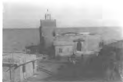
4. Castillo del Bil Bil en obras. 1934.
