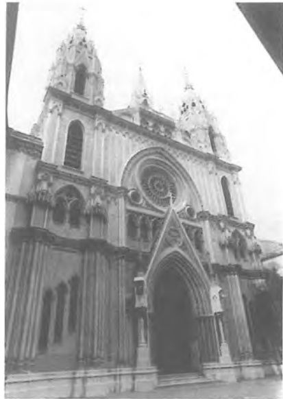
4. Fachada Principal. Iglesia del Sagrado Corazón.
