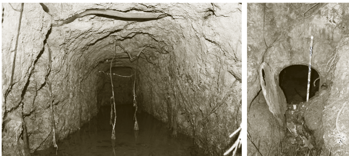
Figura 8. Mina de agua del arroyo de Valsequillo. Entrada por galería de desagüe e interior
