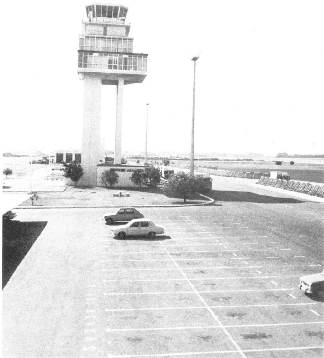
FOTO 1 Torre de Control del Aeropuerto de Málaga Churrriana. (Málaga)
