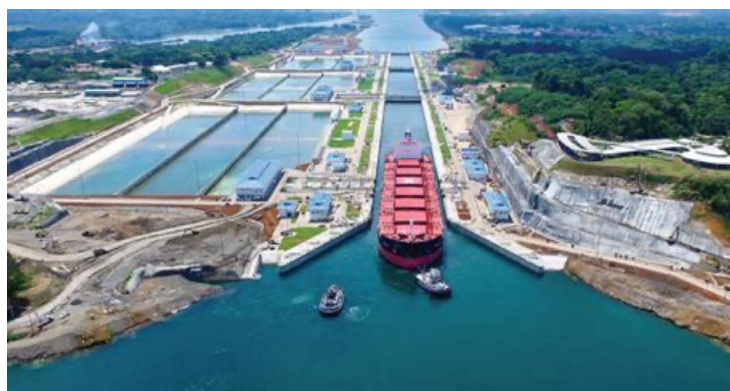
Figura 3. Vista de la de nueva sección ampliada del Canal de Panamá. Figure 3. View of the new enlarged section of the Panama Canal.
