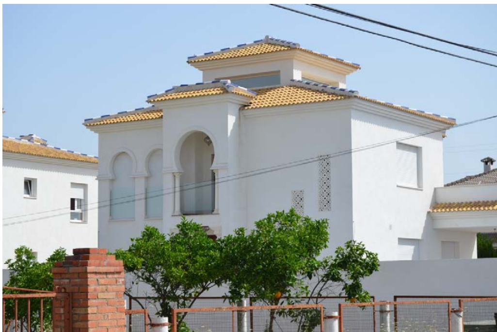
Figura 8. Construcción reciente que refleja la complejidad arquitectónica de la edificación
