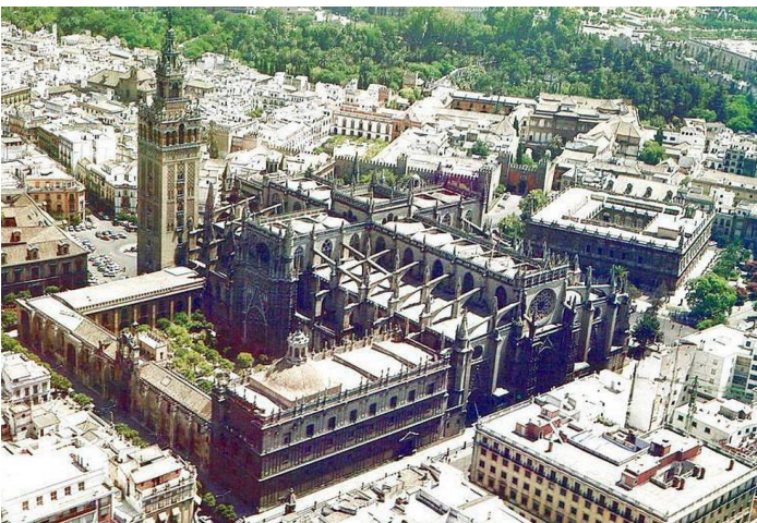
Vista general de la catedral de Sevilla y otros edificios colindantes
