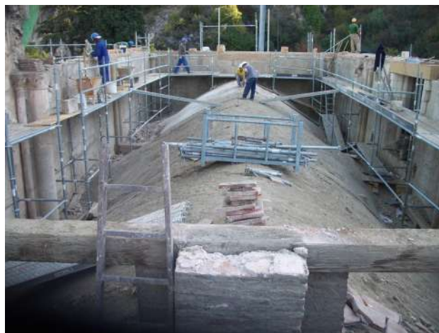
Vista del trasdós de la bóveda y de los restos góticos de la primitiva nave central tras el desmontado de la cubierta.
