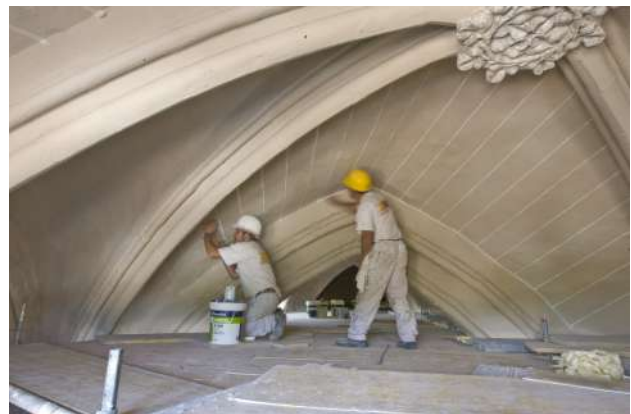
Pintado del despiece en bóvedas.
