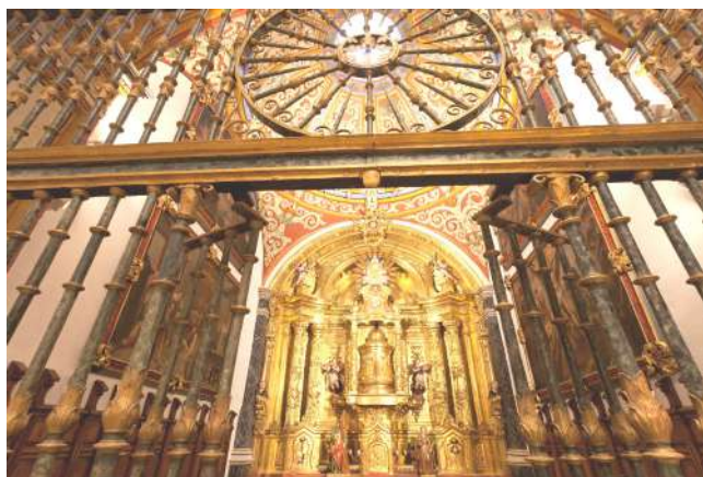
Capilla de San Andrés una vez restaurada y recuperadas sus pinturas barrocas.
