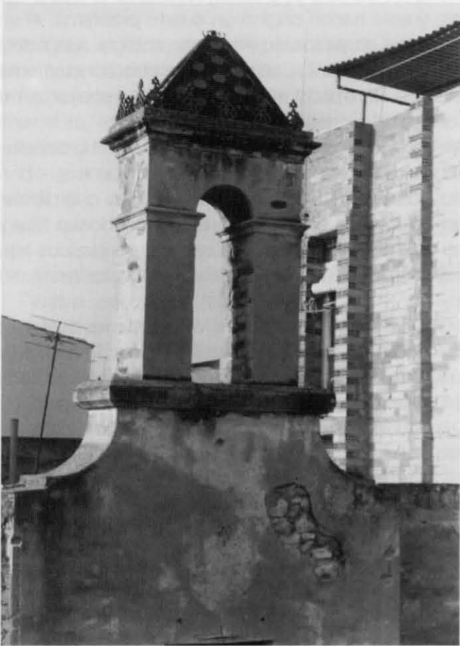
Vista del campanario del Hospital (Foto Enfoc).
