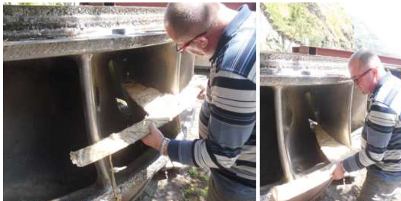
Figura 1. Inspección inicial del estado de la pieza.
