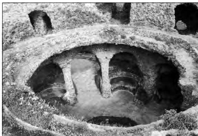
**Figura 9.** Toma superior de la zona central. El agua inundaría parcialmente el pasillo circular de *opus signinum* y, mediante trampillas, se permitiría el paso a las distintas galerías. En este caso, la de la derecha parece tener una clara tendencia por su desnivel a desaguar. La de la izquierda, compartimentada para el reparto. Y la central, que es la más orientada al este, es nuestra principal opción para haber realizado la acometida de agua. Imagen obtenida de CONESA BERNAL (1982, p. 3)
