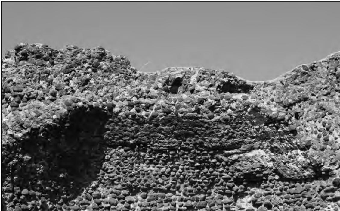
**Figura 13.** Vista desde el exterior de la bóveda de la sala 3. En la pared de esta bóveda no existen aberturas visibles. La única es la situada en la parte central de la imagen, por encima de lo que queda de ella. Por eso pensamos que esa canalización, forrada interiormente con ímbrices, pudo trasportar el agua hasta la zona central de la bóveda, y permitir una ducha desde el centro de la sala
