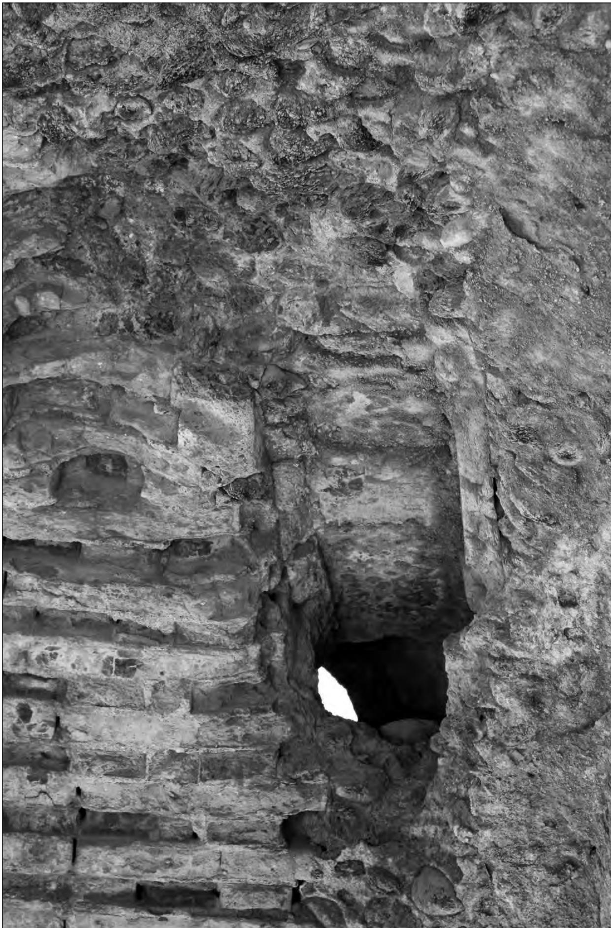
**Figura 12.** Vista en detalle de la canalización en el acceso a la sala 3
