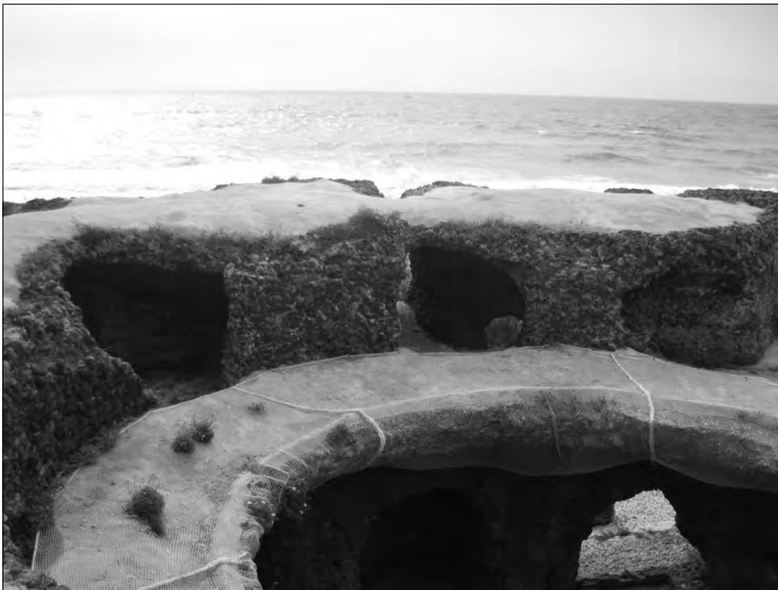
**Figura 8.** Fotografía de tres de las aberturas, las situadas al este y al sur. El pasillo circular de *signinum* está en proceso de destrucción, de ahí las redes de protección. Pensamos que es muy posible que originalmente este pasillo estuviera soportado por columnas en la planta baja. Una vez desaparecidas estas columnas, la estructura se va derruyendo paulatinamente
