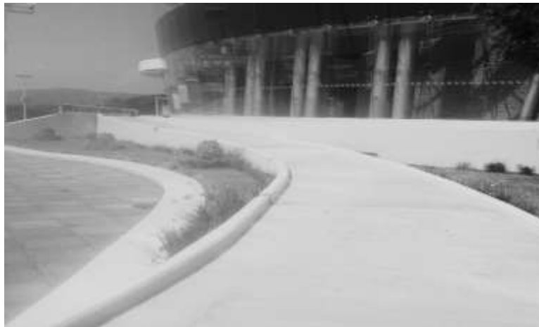
Imagen 2. Entrada principal de Edificio Central. Archivo propio.
