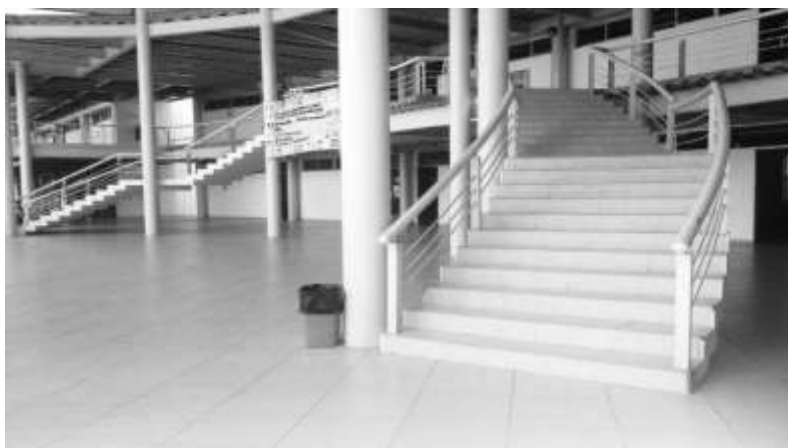
Imagen 8. Escalones para llegar a las aulas. Archivo propio.
