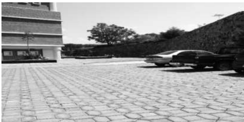
Imagen 3. Estacionamiento del Edificio Central. Archivo propio.
