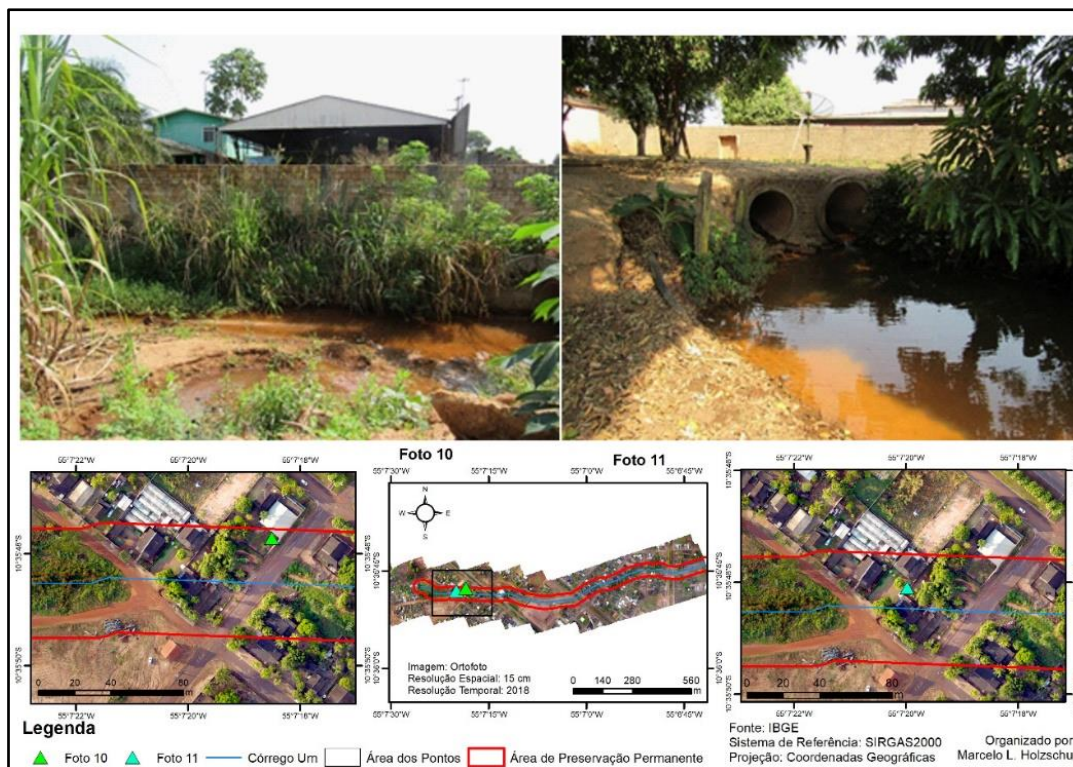
Figura 10: Ponto de observação 8 – Edifício comercial e habitações construídas sobre o Córrego “Um” - Terra Nova do Norte, Mato Grosso
