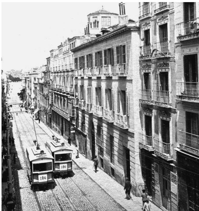
Figura 7: Tranvías de Estaciones y Mercados ya electrificados circulando en doble vía por la calle de Leganitos, 1905. Fuente: Autor desconocido. [IZQUIERDO y MARIBLANCA, 2007, p. 113].
