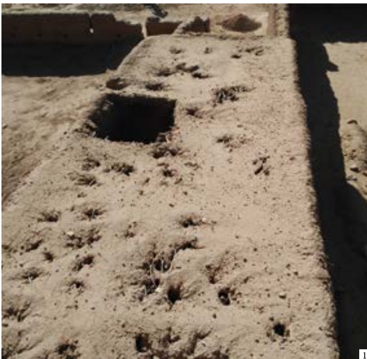
The roof of the south-facing anteroom before and after its reconstruction | Cubierta de la antesala meridional antes y después de su reconstrucción | Cobertura da antecâmara meridional antes e depois da sua reconstrução
