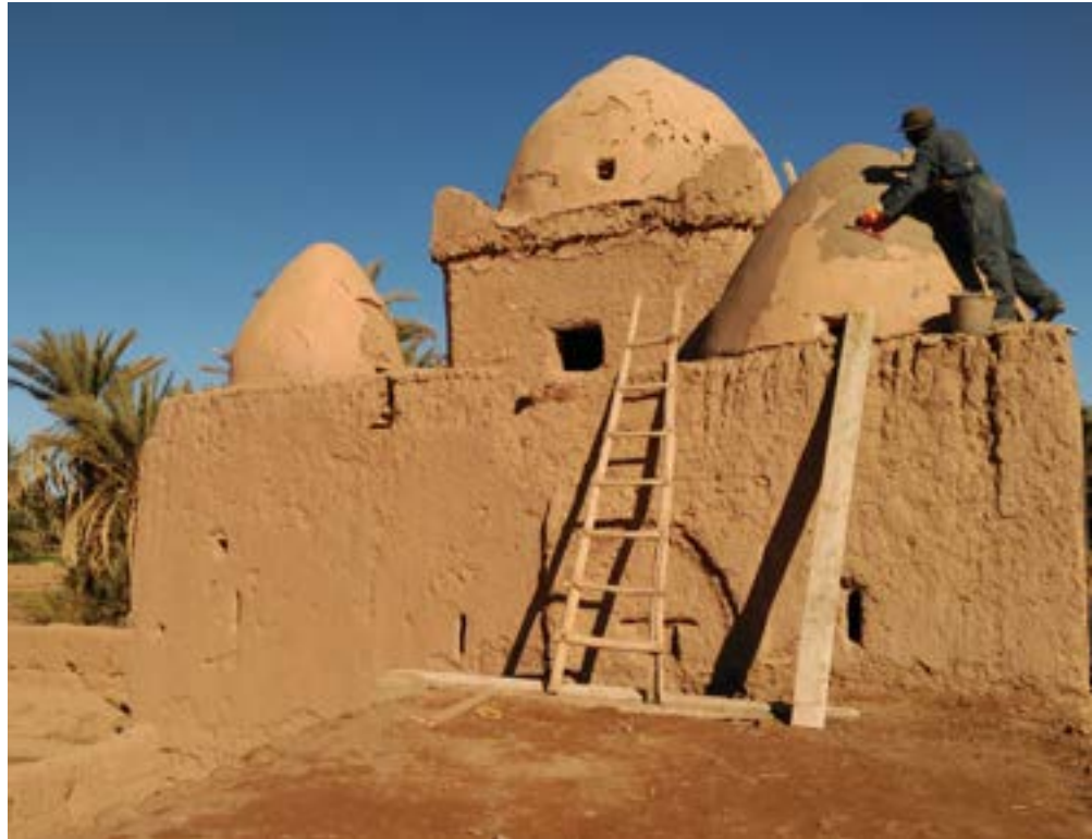
Restoration works of the domes | Trabajos de restauración de las cúpulas | Trabalhos de restauração das cúpulas
