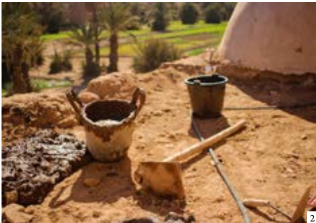
1: Roof construction with tamarisk branches and reed mats 2: Last layer of mud on the roof 3: Tamarisk branches of the roof of the Marabout before restoration | 1: Construcción del techo con vigas de tamarisco y esteras de caña 2: Última capa de barro en el techo 3: Vigas de tamarisco de la cubierta del Morabito antes de la restauración | 1: Construção do teto com vigas de tamarisco e esteiras de cana 2: Última camada de barro no teto 3: Vigas de tamarisco da cobertura do Marabu antes da restauração
