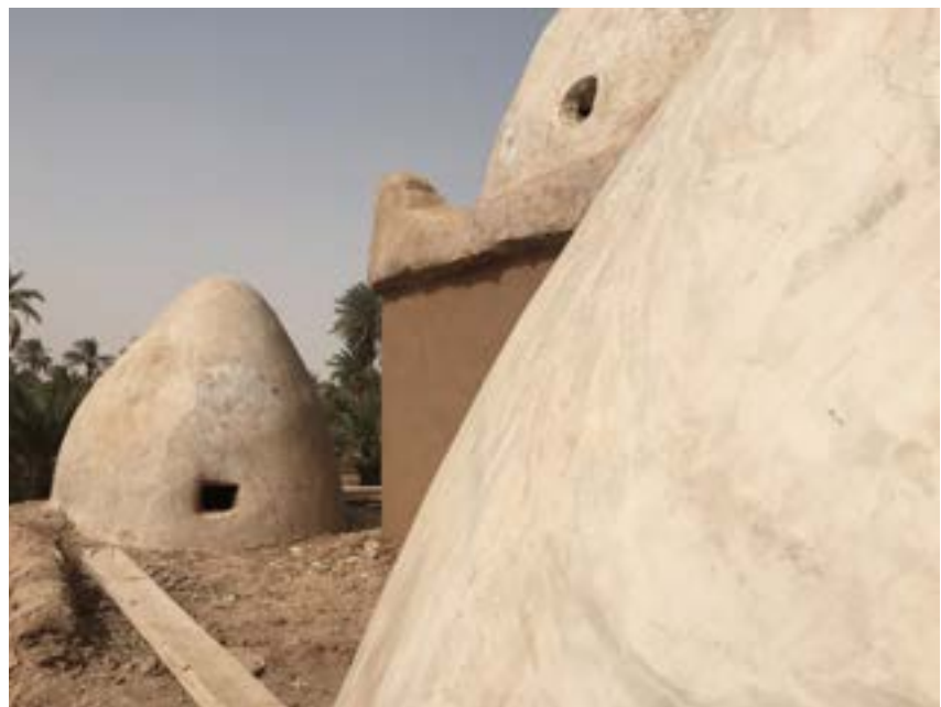
Exterior of the restored domes | Exterior de las cúpulas restauradas | Exterior das cúpulas restauradas
