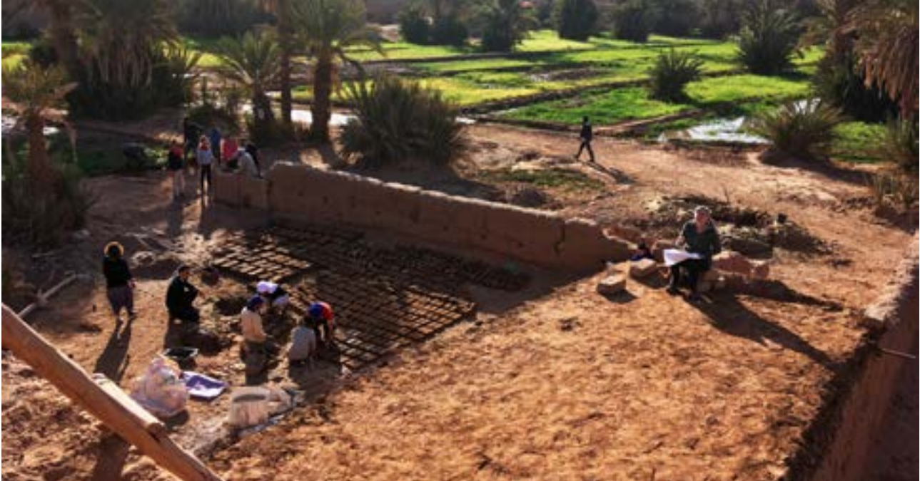
Participants and local masters working together on the restoration of the Marabout | Participantes y maestros locales trabajando en la restauración del Morabito | Participantes e mestres locais a trabalharem na restauração do Marabu
