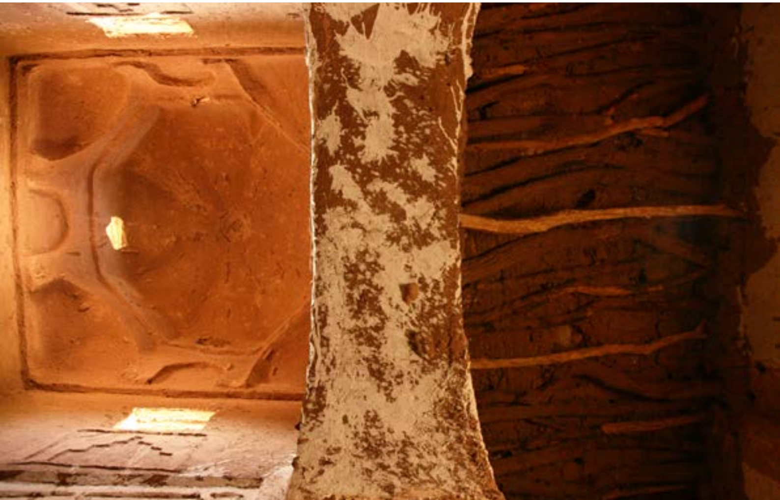
Bottom-up interior view of the central dome and the floors | Vista interior de la cúpula central y un forjado | Vista interior da cúpula central e uma estrutura de madeira
