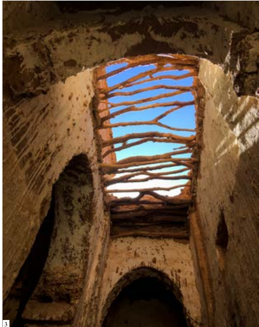
1: Roof construction with tamarisk branches and reed mats 2: Last layer of mud on the roof 3: Tamarisk branches of the roof of the Marabout before restoration | 1: Construcción del techo con vigas de tamarisco y esteras de caña 2: Última capa de barro en el techo 3: Vigas de tamarisco de la cubierta del Morabito antes de la restauración | 1: Construção do teto com vigas de tamarisco e esteiras de cana 2: Última camada de barro no teto 3: Vigas de tamarisco da cobertura do Marabu antes da restauração
