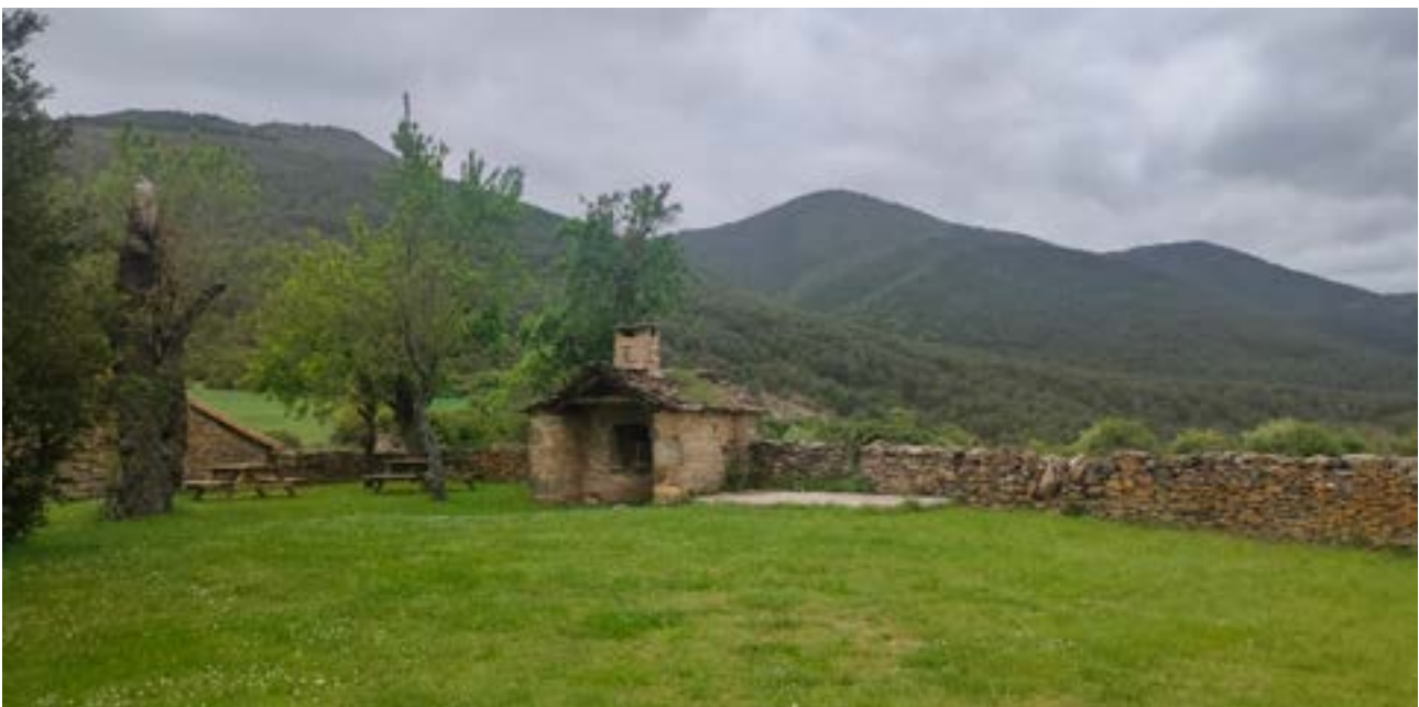
Bakehouse before restoration in Allué | Horno de pan antes de su intervención, en Allué | Forno de pão antes da sua intervenção, em Allué
