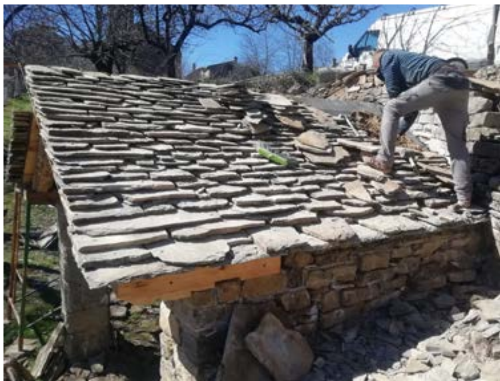
Waterproofing and laying of slabs | Impermeabilización y colocación de las losas | Impermeabilização e colocação das lajes
