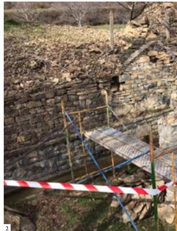
1, 3: Washhouse building before restoration, in Barbenuta 2: 2: Fully dismantled roof | 1, 3: Edificio del lavadero antes de la restauración, en Barbenuta 2: Cubierta completamente desmantelada | 1, 3: Edifício do lavadouro antes da restauração, em Barbenuta 2: Desmantelamento total da cobertura
