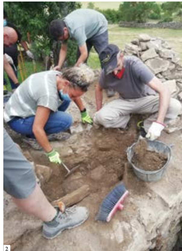
1: Removal of infill over the vault with workshop participants 2: Full dismantling of the roof | 1: Retirada del material de relleno sobre la cúpula con los asistentes al taller 2: Desmontaje completo de la cubierta | 1: Retirada do material de enchimento sobre a cúpula com os participantes do workshop 2: Desmontagem completa da cobertura
