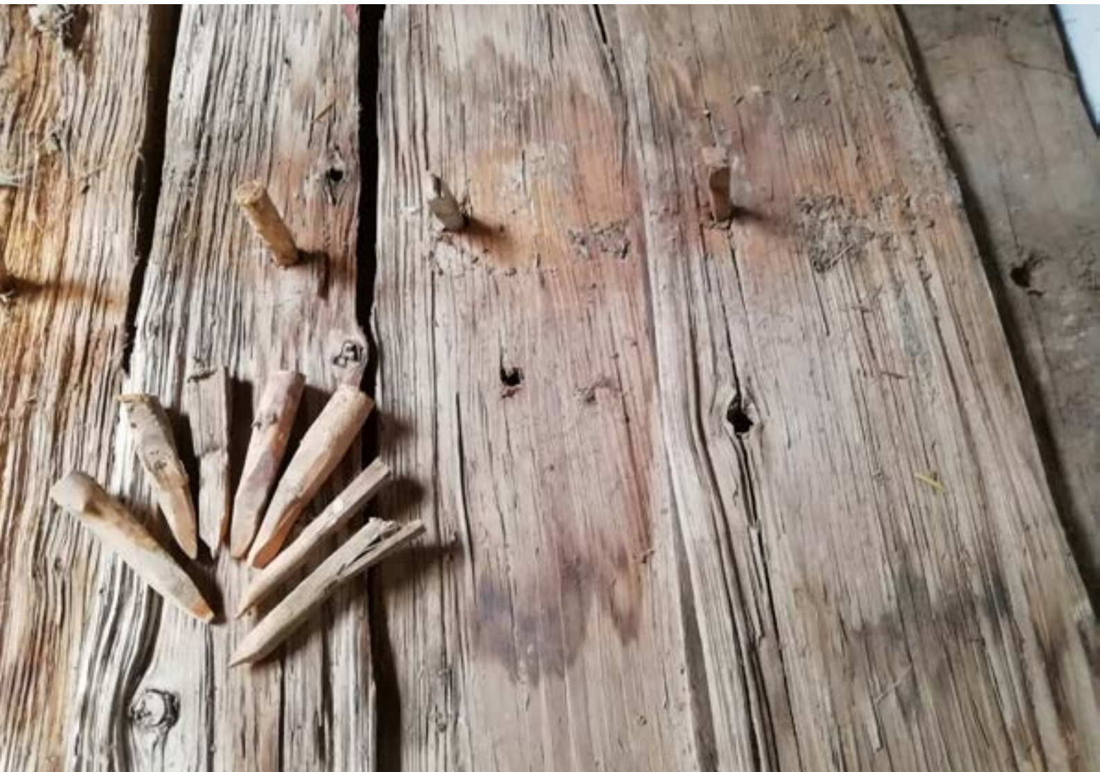
Pine rechas and pegs | Rechas y clavijas de pino | Rechas e cavilhas de pinheiro
