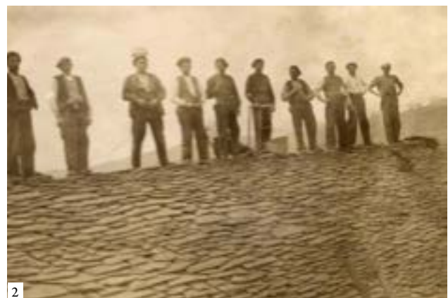
1: Building of a house in Sabiánigo, 1934 2: Building of a house in Sabiánigo, 1934. Detail of the finished roof with the piqueros | 1: Casa en construcción en Sabiánigo, año 1934 2: Casa en construcción en Sabiánigo, año 1934. Detalle de la cubierta terminada y de los piqueros | 1: Casa em construção Sabiánigo, ano 1934 2: Casa em construção em Sabiánigo, ano 1934. Pormenor da cobertura terminada e dos piqueros (Family archive of Rosa Pueyo)
