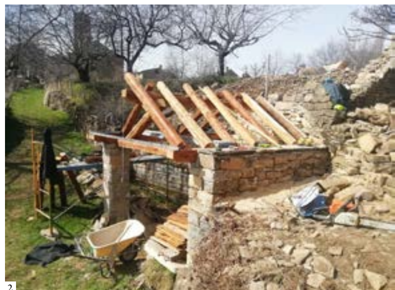
1: Cleaning of salvaged rechas 2: Assembly of the timber framework | 1: Limpieza de la recha recuperada 2: Montaje de la estructura de madera | 1: Limpeza da recha recuperada 2: Montagem da estrutura de madeira
