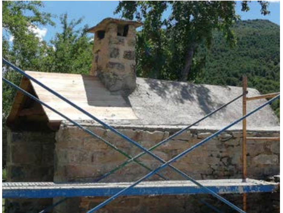
Restoration of the wooden roof structure and formation of its two slopes with new materials | Restauración de la estructura de cubierta en madera y formación de las dos aguas con el nuevo material | Restauração da estrutura da cobertura em madeira e formação das duas águas com o novo material
