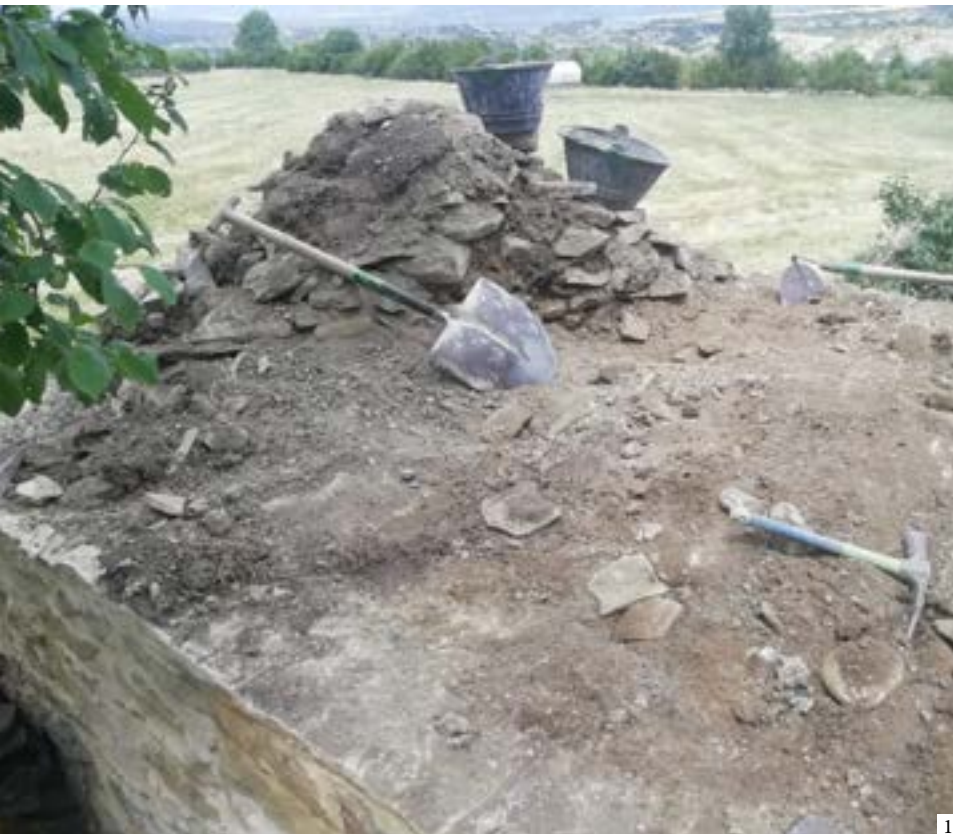
1: Removal of infill over the vault with workshop participants 2: Full dismantling of the roof | 1: Retirada del material de relleno sobre la cúpula con los asistentes al taller 2: Desmontaje completo de la cubierta | 1: Retirada do material de enchimento sobre a cúpula com os participantes do workshop 2: Desmontagem completa da cobertura
