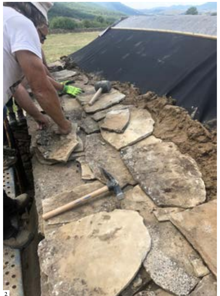
1: Laying of leras and beginning of the eave 2: Laying of slabs over the mud bedding and a waterproof membrane | 1: Colocación de leras e inicio del alero 2: Colocación de losas sobre una cama de barro y la lámina de impermeabilización | 1: Colocação de leras e início do beiral 2: Colocação das lajes sobre uma camada de barro e a lâmina de impermeabilização
