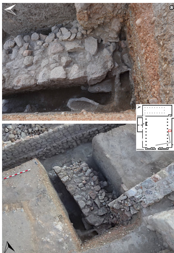
Figura 15. Finalización del muro 3640 en conexión con las piletas preexistentes
