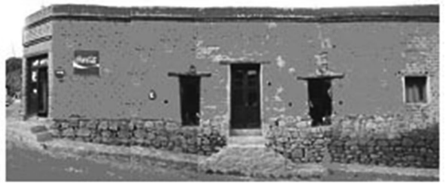
Esquema del edificio con un local de ramos generales y local regional
