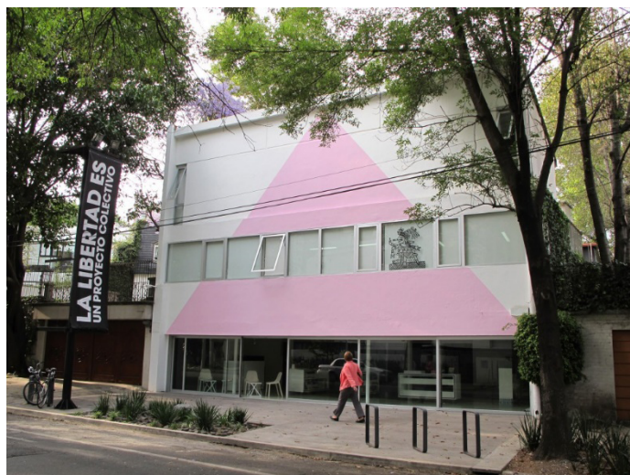
Figura 7. Instalación de fachada en Sala de Arte Público Siqueiros, Ciudad de México, febrero de 2013. Fuente: https://carlosmotta.com/project/shape-of-freedom/
