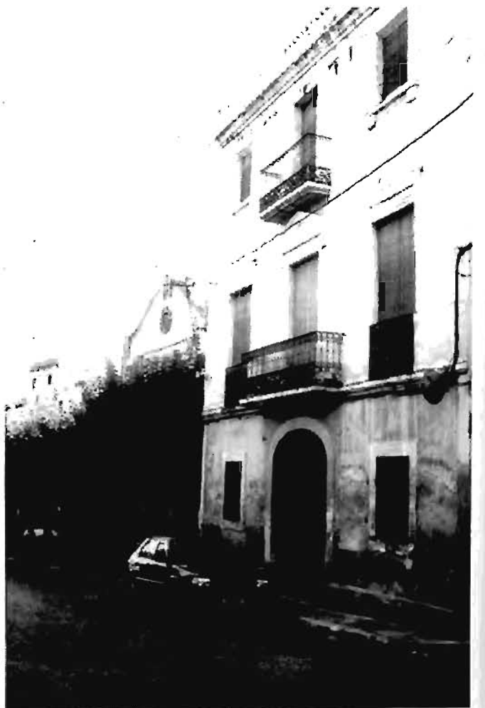
Edifici del carrer Major núm. 14, incautat, i Seu Local del PSUC.
