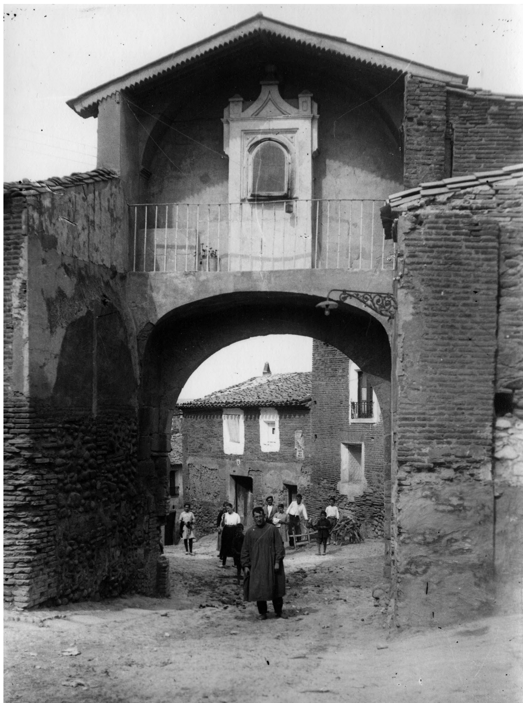
Figura 3. Arco del Planillo. Única puerta que subsiste del recinto amurallado de Calahorra. Fondo Bella.
