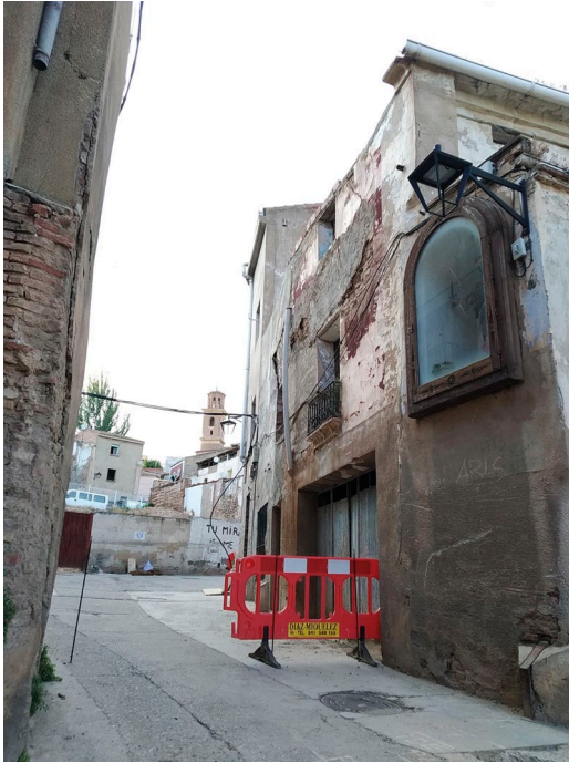
Figura 2. Acceso a calle Arrabal donde estuvo la puerta de San Miguel. Foto: A. Martínez.
