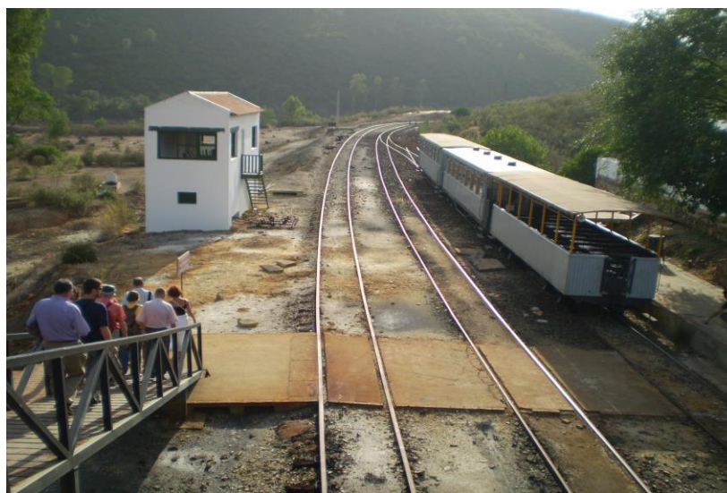
Tren y línea férrea minera rehabilitada para la historia y el servicio a la comunidad. Rio Tinto
