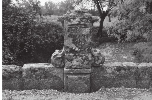
Detalle de un puente. Foto del autor.
