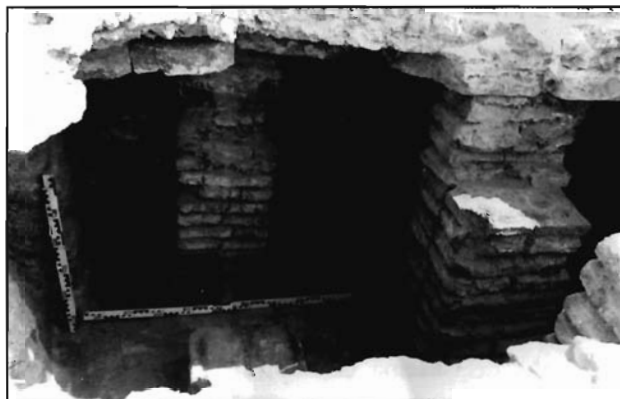
Lámina 20. Detalle del sistema de suspensura documentado bajo el pavimento del alveus del caldarium : dos columnillas centrales integradas por parejas de ladrillos rectangulares y columnillas de un solo ladrillo adosadas a los muros perimetrales. Entre todas soportan una plataforma de 6 ladrillos bipedales sobre la que se dispone el pavimento de mortero hidráulico.
