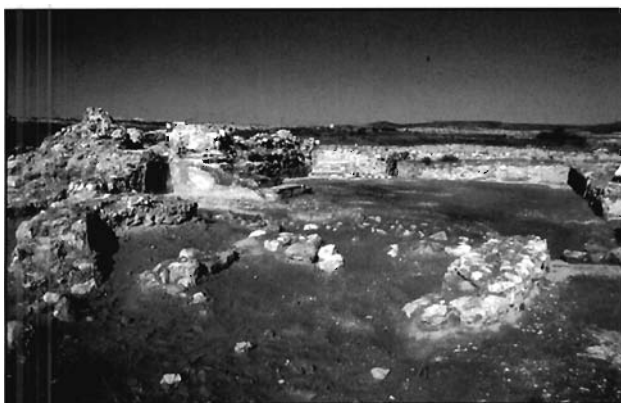
Lámina 11. Vista posterior de la exedra. A la derecha, restos del pavimento del pasillo de servicio que rodeaba la misma. En segundo término, escaleras de acceso a las estancias calefactadas y la gran sala del frigidarium .
