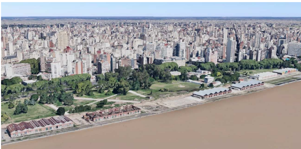
Figura 3: Remodelación de los galpones (década de 2010). A la derecha: El CEC y el CJ.
