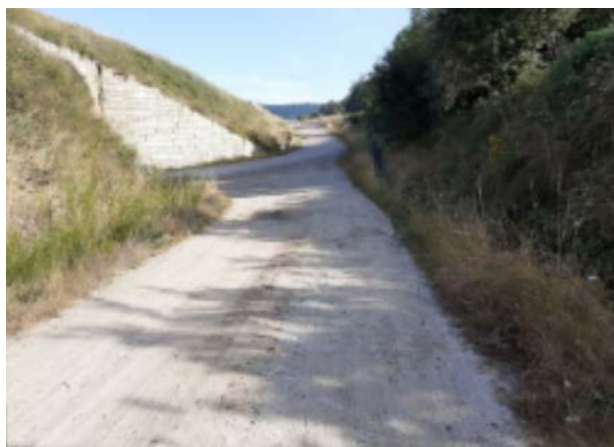
Fig. Vía de servicio en el P.K. 8+700 (margen izquierda). Se aprecia al fondo, a la izquierda, la embocadura del paso inferior que conecta ambas márgenes de la Autovía.
