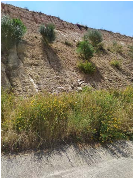
Fig. Talud con problemas de “chirrup” sobre la vía principal (P.K. 7+200): frente de talud (izquierda) y cuneta de seguridad al pie del mismo (derecha).
