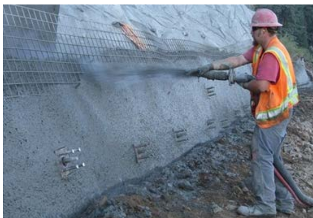
Fig. Ejemplo de puesta en obra de hormigón proyectado en un talud de carretera (Fuente: CETIM)
