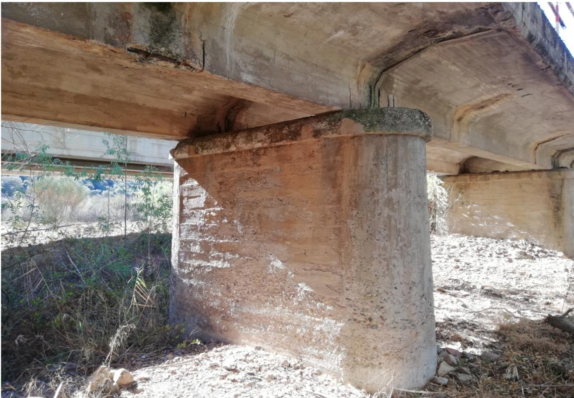
**Detalle de una pila y del tablero. Se puede visualizar el deterioro del hormigón armado y la unión entre tramos.**
