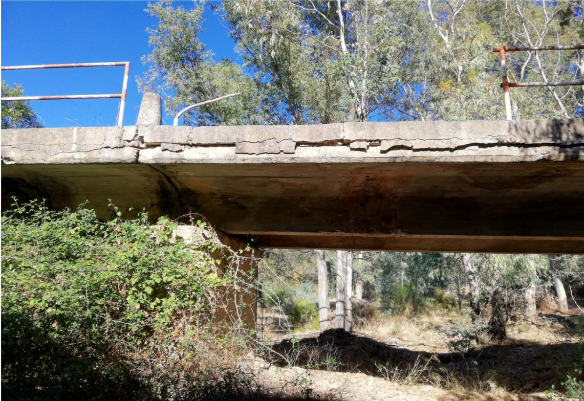
**El tablero necesitaría reparaciones en el revestimiento y parte de la barandilla de metal se ha perdido**
