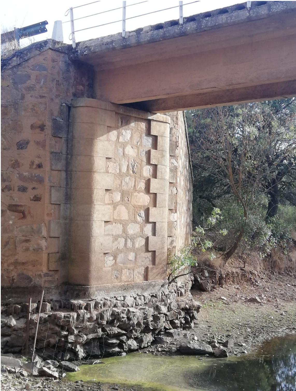
**Detalle del estribo izquierdo, sobre una base de piedra para evitar su desgaste. La viga es un solo tramo recto de hormigón de sección T+T, según el modelo oficial de puentes económicos de hormigón armado para caminos vecinales de Juan Manuel de Zafra**
