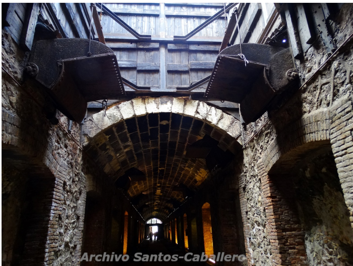
Fig. 6. Túnel de descarga del Embarcadero del Hornillo. Archivo Santos-Caballero
