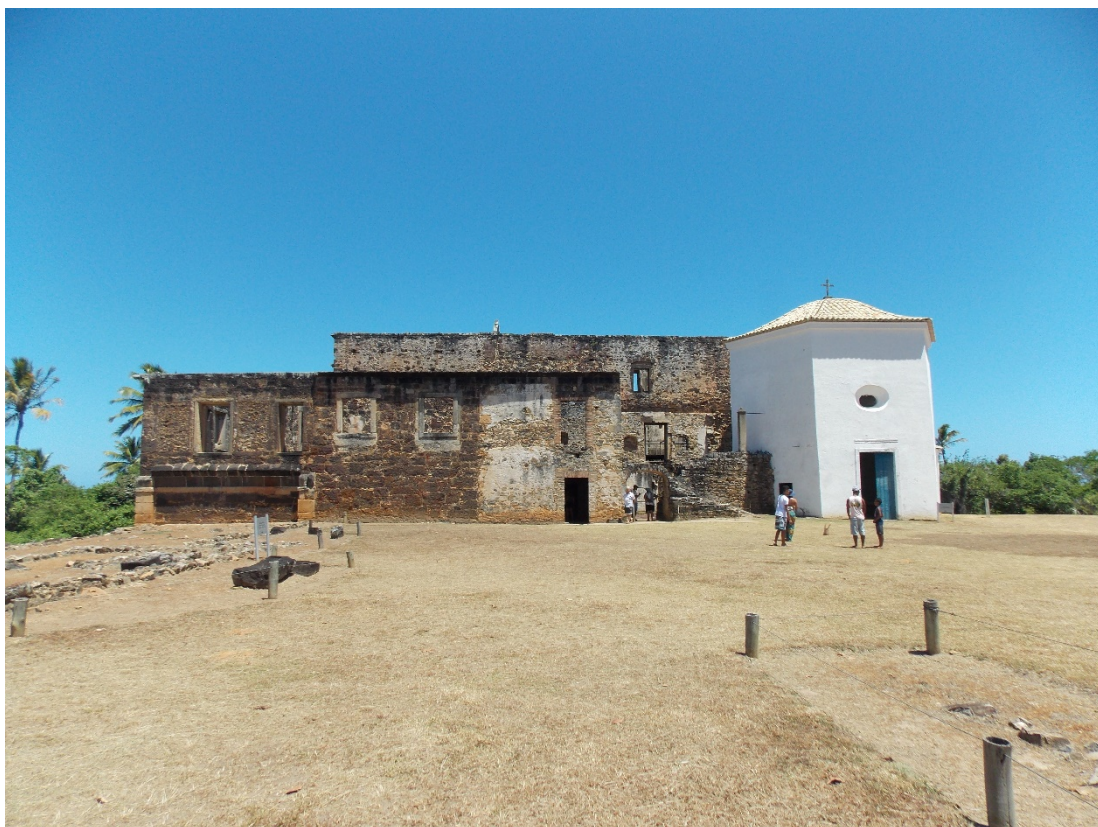
Figura 2: Vista frontal da estrutura. Castelo Garcia d'Ávila (Mata de São João/Praia do Forte, Bahia, Brasil).
