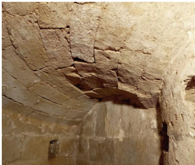
Fig. 7. Castello di Copertino, all'intradosso della volta elicoidale sono evidenti le correzioni a scalpello nella parte iniziale della costruzione.
