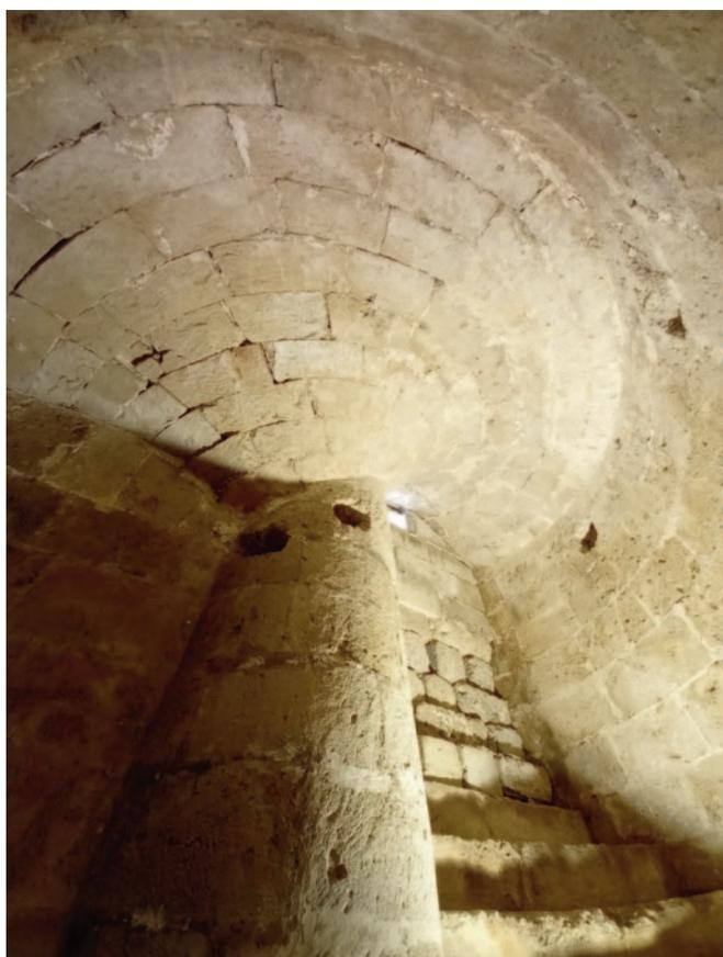
Fig. 1. Castello di Copertino, la volta elicoidale sulla scala a chiocciola.
