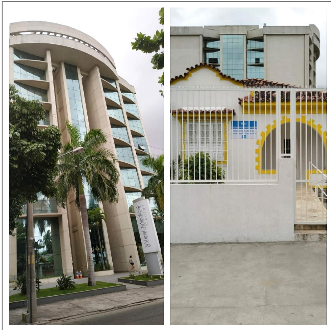
Figura 21 - Fachada do West Medical Center na Rua Ivo do Prado e casas na testada da Rua Campo Grande com o prédio West Medical Center ao fundo
