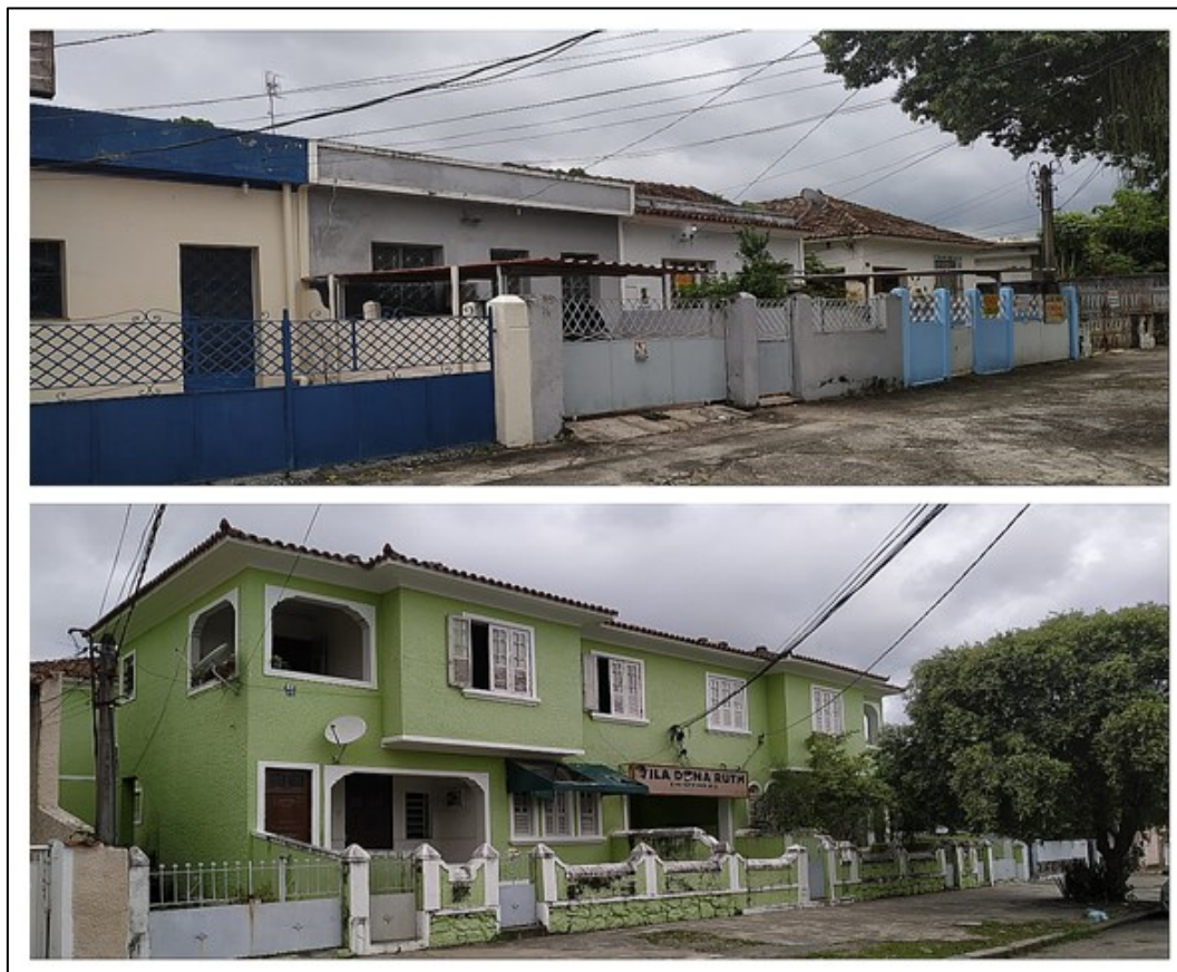
Figura 20 - Vila Dona Ruth e casas na Rua Domingos do Couto, Campo Grande – Rio de Janeiro.
