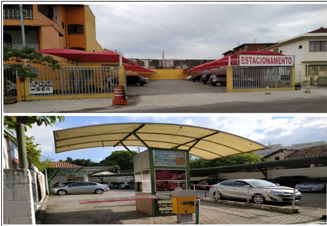
Figura 3 - Estacionamentos nas ruas Alfredo de Morais e Amaral Costa, centro do bairro de Campo Grande, Rio de Janeiro
