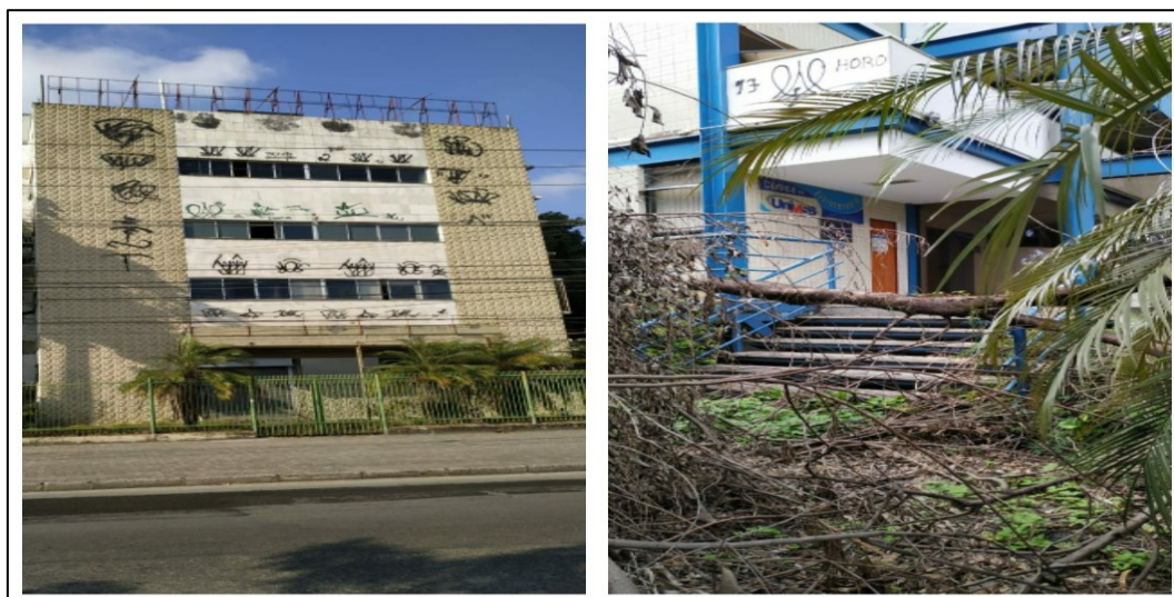
Figura 7 - Prédios abandonados do Colégio Afonso Celso, na Rua Engenheiro Trindade, e Centro Universitário Moacyr Sreder Bastos, na Rua Amaral Costa, Campo Grande – Rio de Janeiro.
