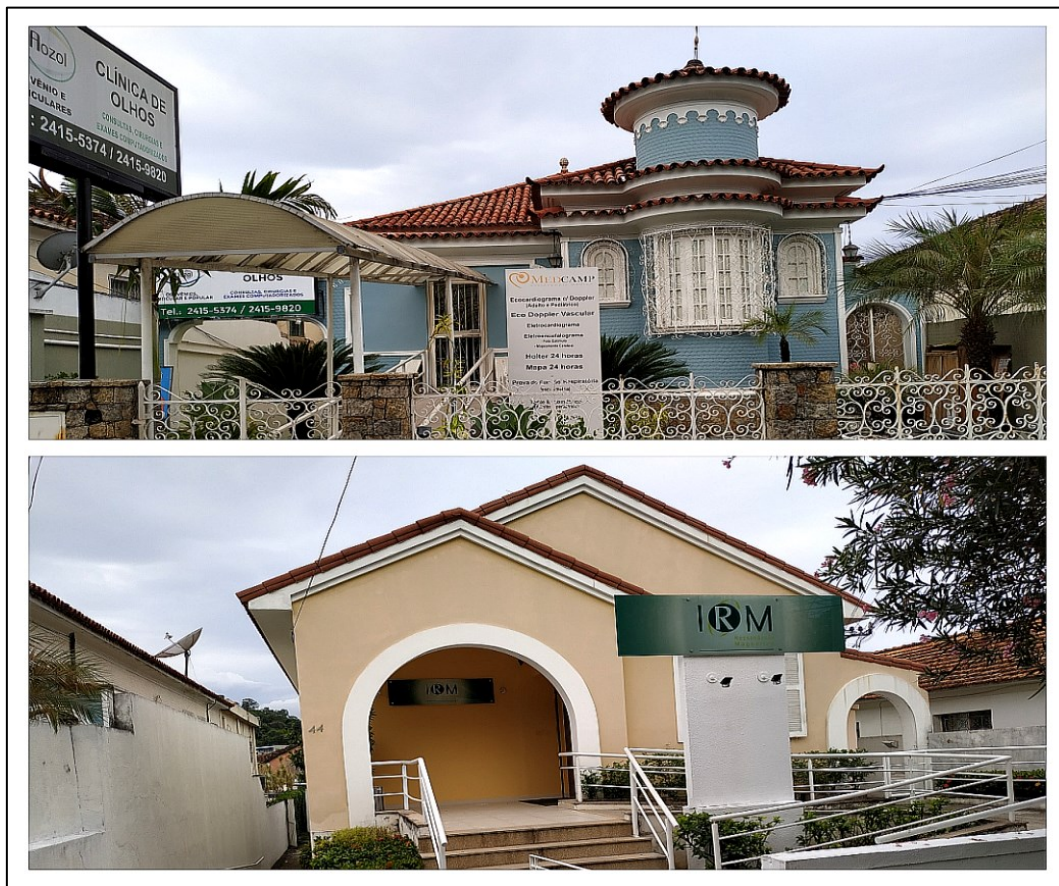
Figura 18 - Casario refuncionalizado para serviços médico-hospitalares na Rua Jaguaruna, Campo Grande, Rio de Janeiro.
