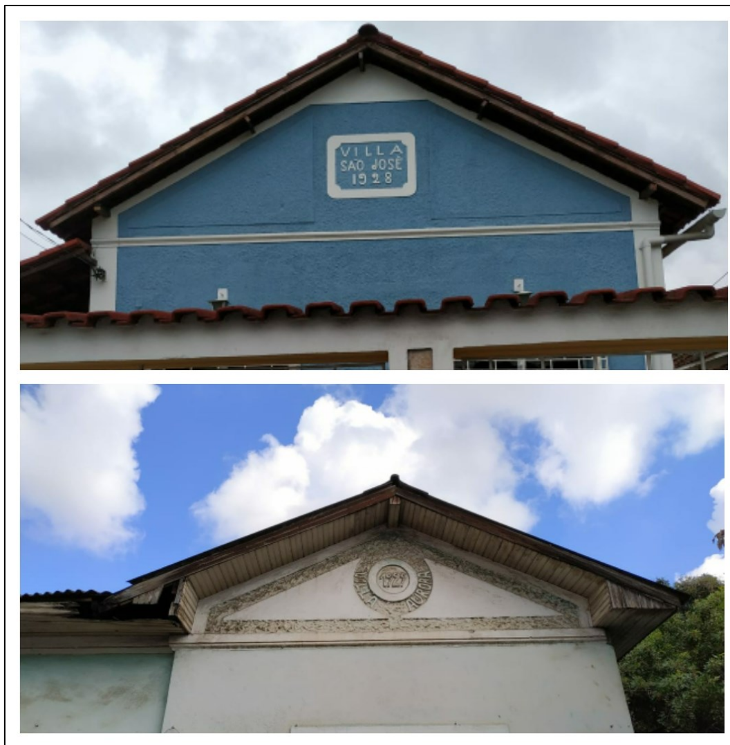
Figura 19 - Casa azul da Villa São José, datada de 1928, na Rua Vítor Alves e casa verde da Villa Aurora, datada de 1929, na Rua Barcelos Domingos, Campo Grande – Rio de Janeiro.
