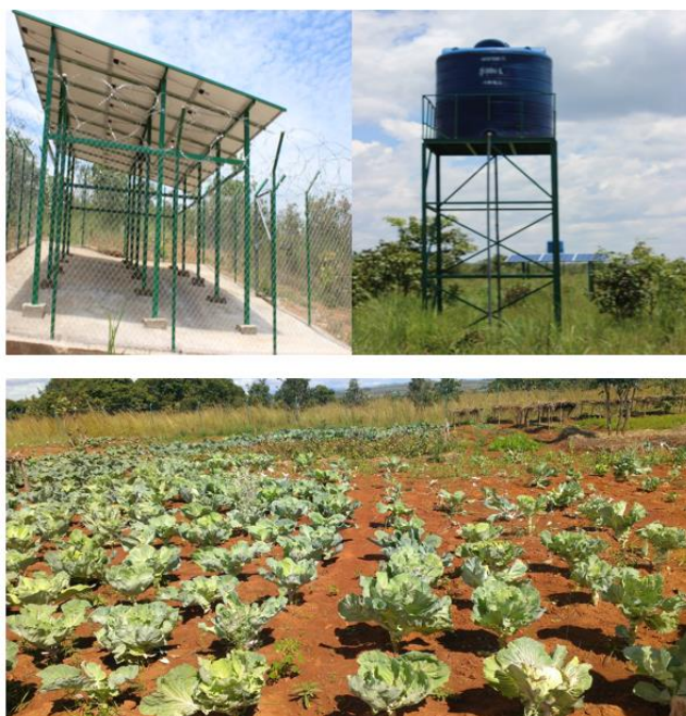
Figura 3. Bomba de captação de água
