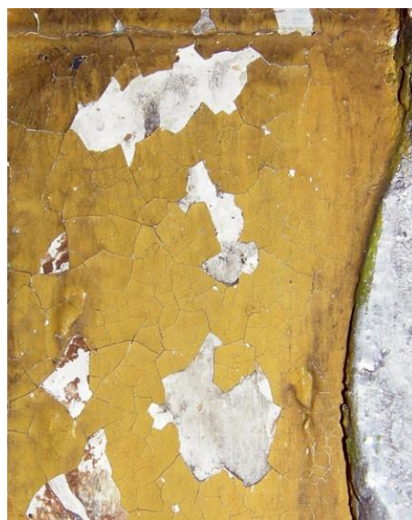
Figs. 24 y 25: Várias lacunas existentes ao nível da policromia y uma rede de microfissuras designadas por craquelês . Capela de São Bartolomeu, Aveiro. Fotos: NR.
