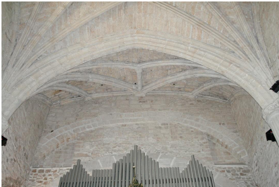
Fig. 6: Bóveda del último tramo del cuerpo del edificio , parroquia de Nuestra Señora de la Asunción, Valdepeñas (Ciudad Real). Foto: JJBC.
