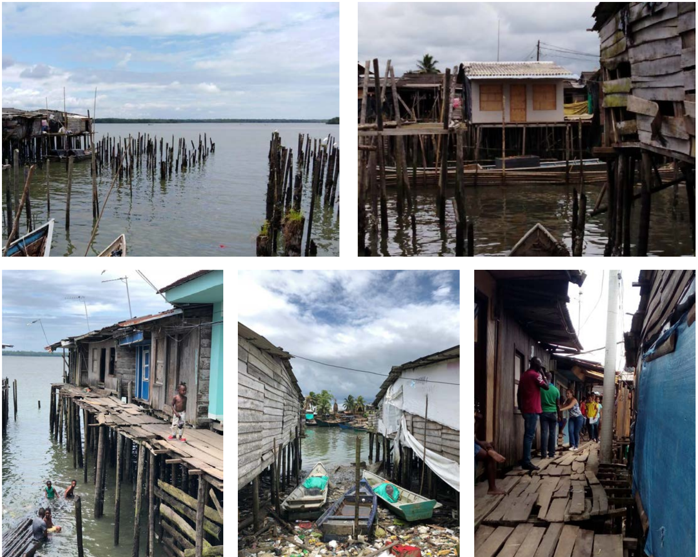
Figura 2. Estructuras existentes en la zona de estudio. Fuente: Elaborada por los autores
