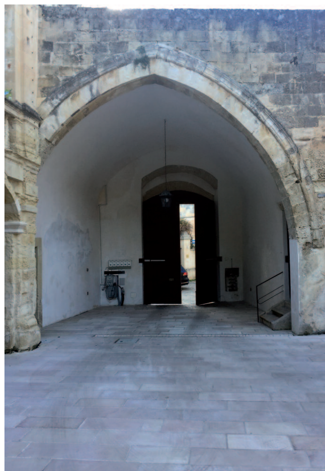
Fig. 13. Lecce. Palazzo dell'Antoglietta, arco d'ingresso sul cortile.
