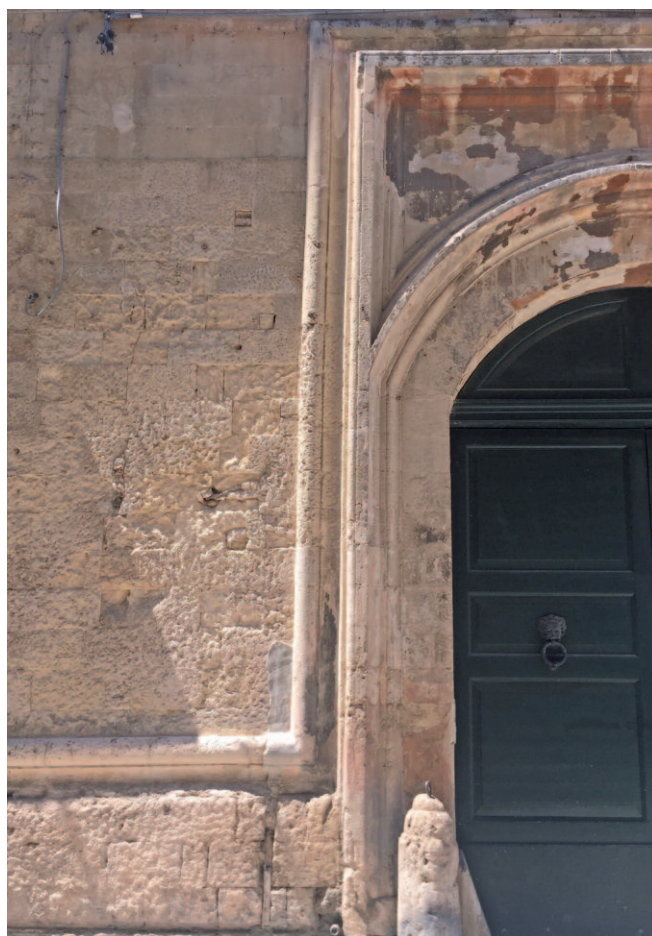
Fig. 10. Lecce. Palazzo Palmieri, particolare del portale.
