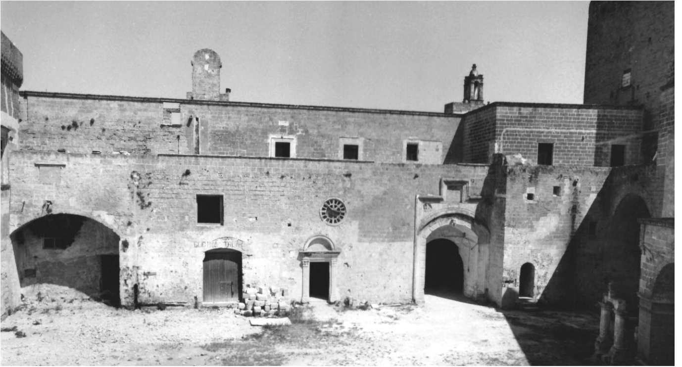
Fig. 4. Copertino. Castello, corte interna.
