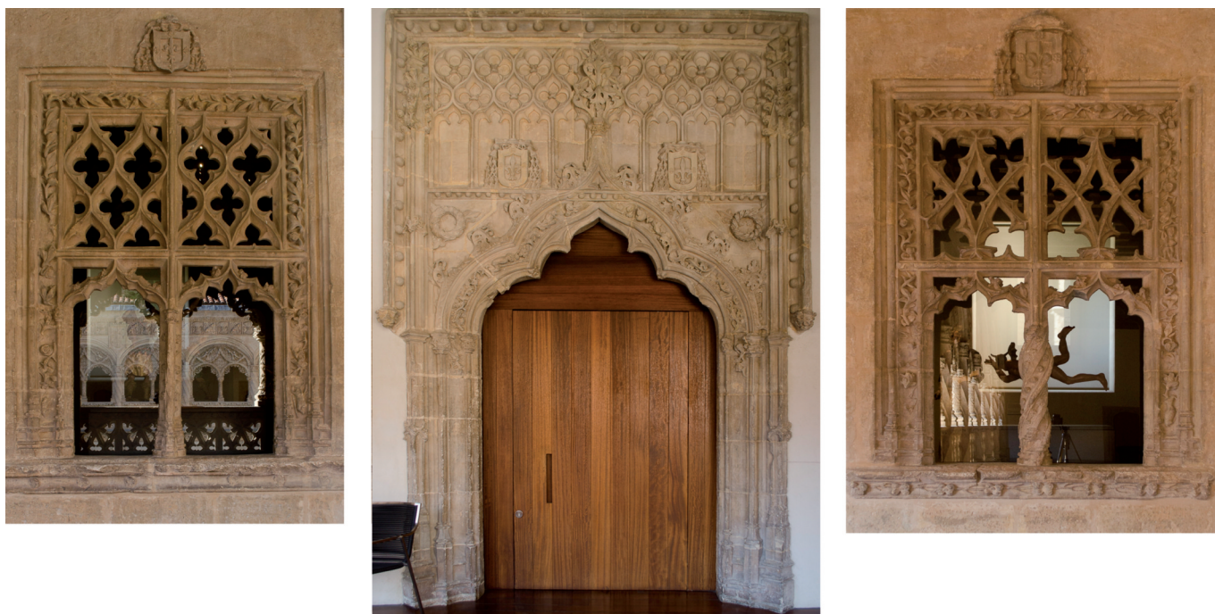
Fig. 8. Valladolid. Colegio de San Gregorio, 1487-1499. Composición con puerta y ventanas de la antigua residencia de Alonso de Burgos en la planta superior.
