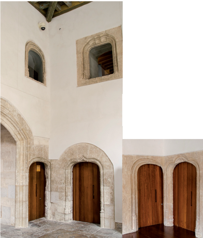
Fig. 4. Valladolid. Colegio de San Gregorio, 1487-1499. Puertas y ventana en escamoteo que servirían a la escalera de caracol y a las celdas.
