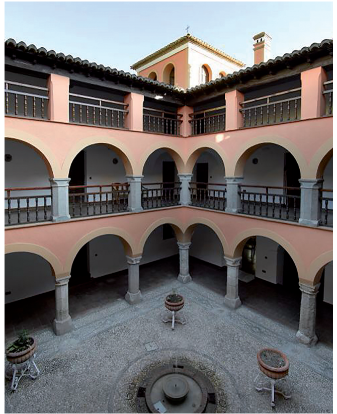
Fig. 11. Granada. Patio de la granja de Baza.
