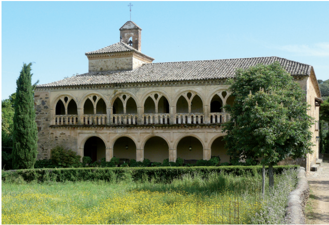
Fig. 4. Guadalupe. Fachada de la granja de Valdefuentes.
