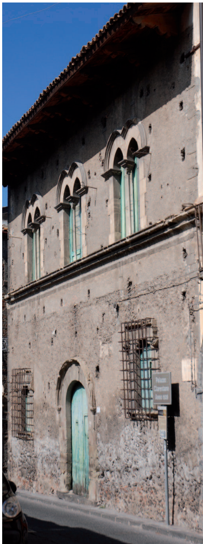
Fig. 9. Randazzo. Palazzo Clarentano, prospetto principale su via Duca degli Abruzzi.
