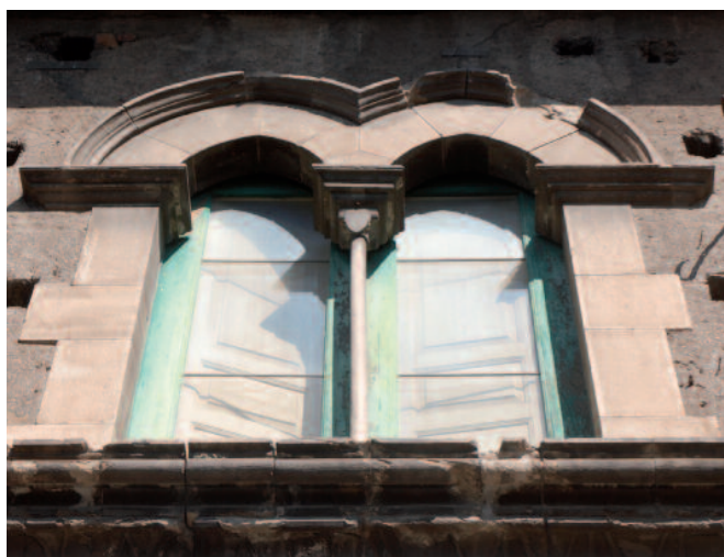
Fig. 11. Randazzo. Palazzo Clarentano, prospetto principale, particolare bifora primo piano.
