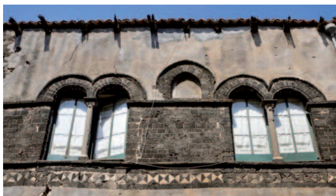
Fig. 2. Randazzo. Casa Scala (già Palazzo reale), prospetto principale, particolare primo piano.
