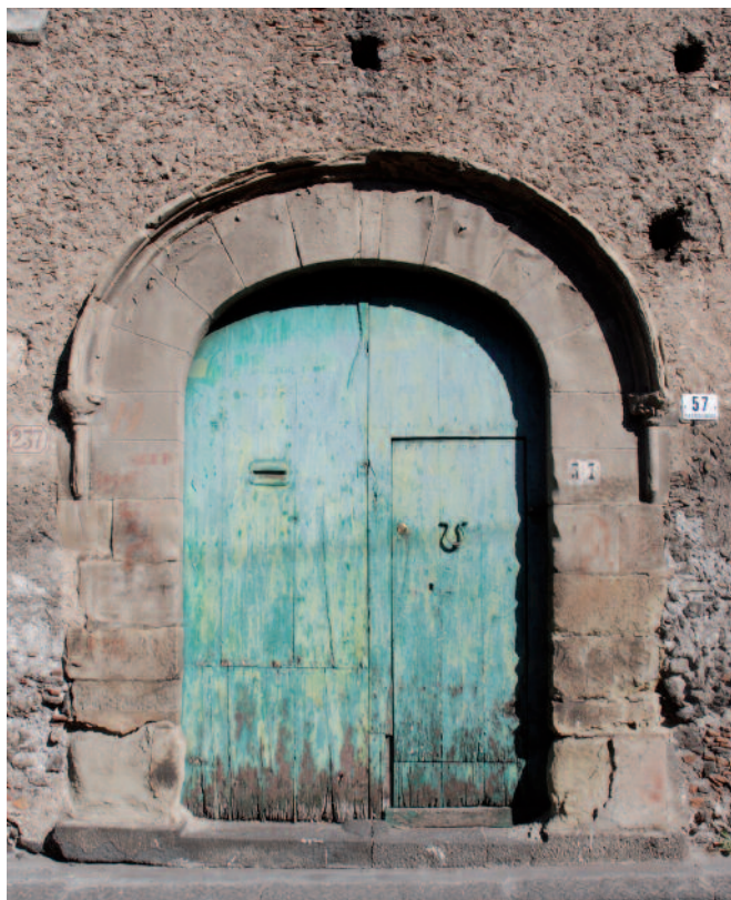
Fig. 10. Randazzo. Palazzo Clarentano, prospetto principale, particolare portone d'ingresso.
