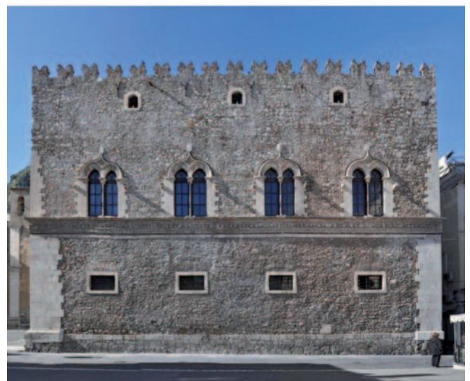
Fig. 13. Taormina. Palazzo Corvaja, veduta dall'alto e prospetto principale.
