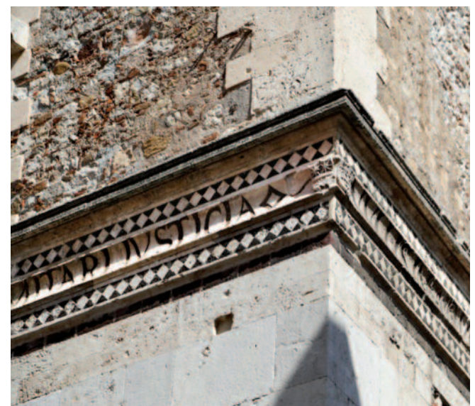
Fig. 14. Taormina. Palazzo Corvaja, prospetto principale, particolare del marcapiano.
