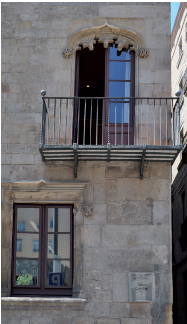
Fig. 11. Barcelona. Palau Centelles, detalle del ventanaje.
