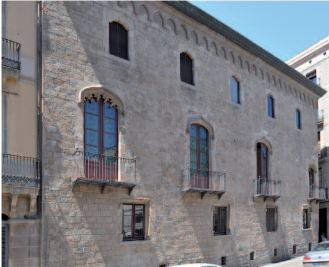
Fig. 10. Barcelona. Palau Centelles, fachada lateral.
