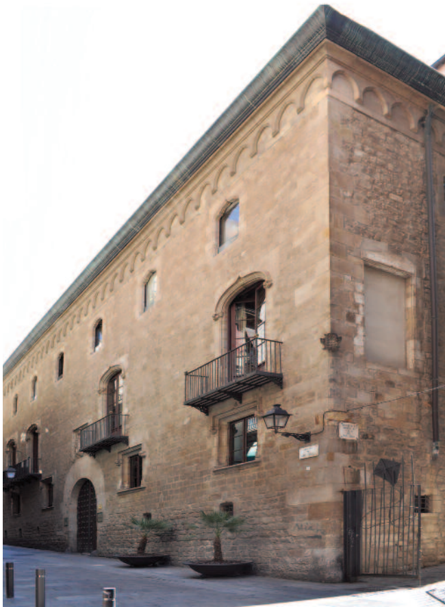
Fig. 1. Barcelona. Palau Centelles, fachada principal.
