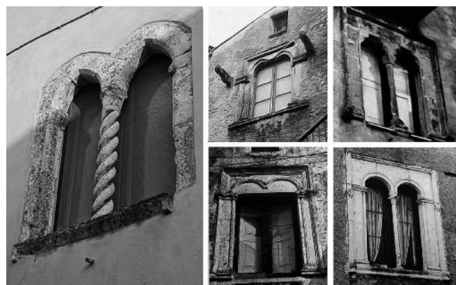
Fig. 3. Tipologie di bifore quattrocentesche in Calabria; da sinistra e dall'alto: Squillace (Catanzaro), bifora nel centro storico; Ajello Calabro (Cosenza), casa Voci; Caloveto (Cosenza), casa Britti; Campagnano (Cosenza), Grangia dei Domenicani (da G. De Marco, L'architettura catalana... , cit., p. 273).
