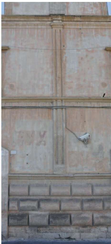
Fig. 14. Cosenza. Palazzo di Pompeo Sersale, 1592, dettagli del sistema di paraste sovrapposte che scandiscono la facciata e dei capitelli ionici e corinzi che le sormontano.
