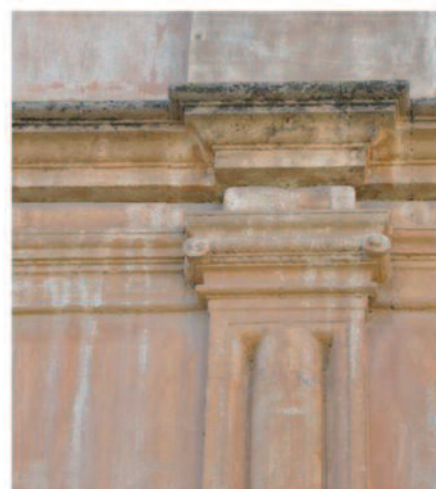
Fig. 14. Cosenza. Palazzo di Pompeo Sersale, 1592, dettagli del sistema di paraste sovrapposte che scandiscono la facciata e dei capitelli ionici e corinzi che le sormontano.
