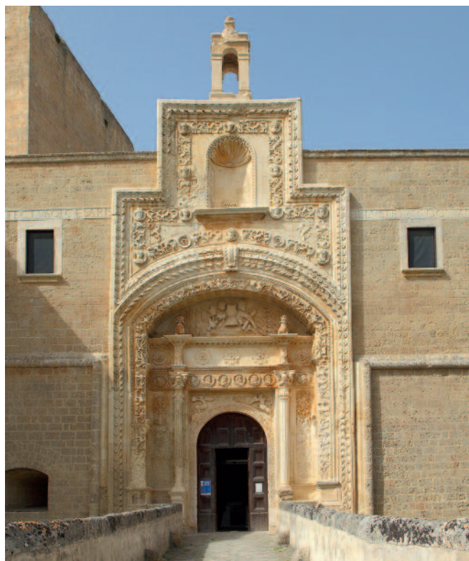
Fig. 8. Copertino. Castello, portale.
