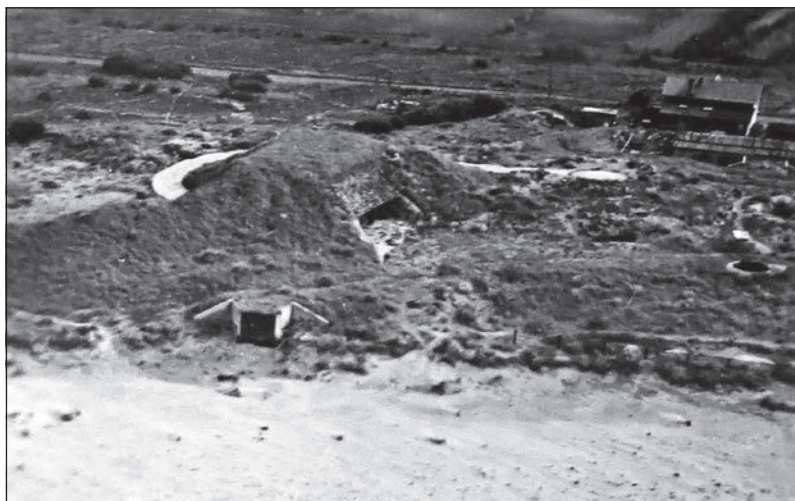
Figura 36. Una de las tres casamatas artilleras dobles, tipo 669D, se aprecia como presenta al frente su muro lateral, reforzado con tierra, que además aumentaba su camuflaje (SHM Rochefort 1W 1849).
