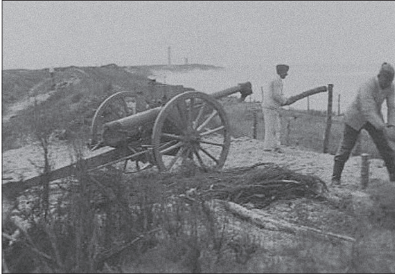
Figura 12. Imagen que muestra el comienzo de los trabajos defensivos en Klara . Se aprecia como los cañones están en posición sobre la cresta de la línea de dunas (DR).
