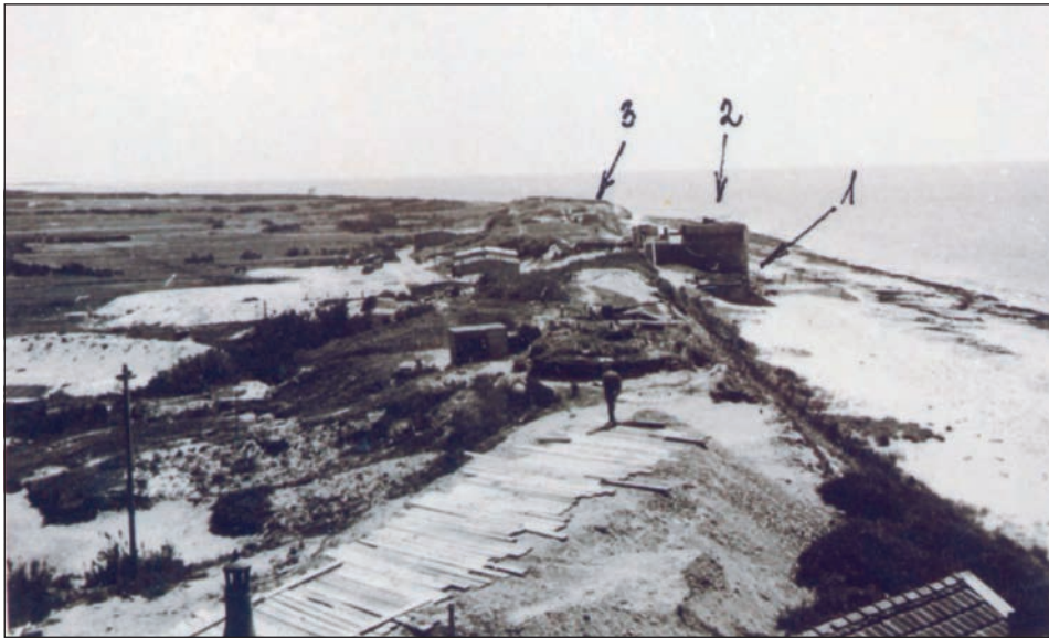
Figura 8. Fotografía de la batería de Kathi con sus tres asentamientos para las piezas de 40 mm señalados con las flechas (NARA, T-1022, rollo 3610).
