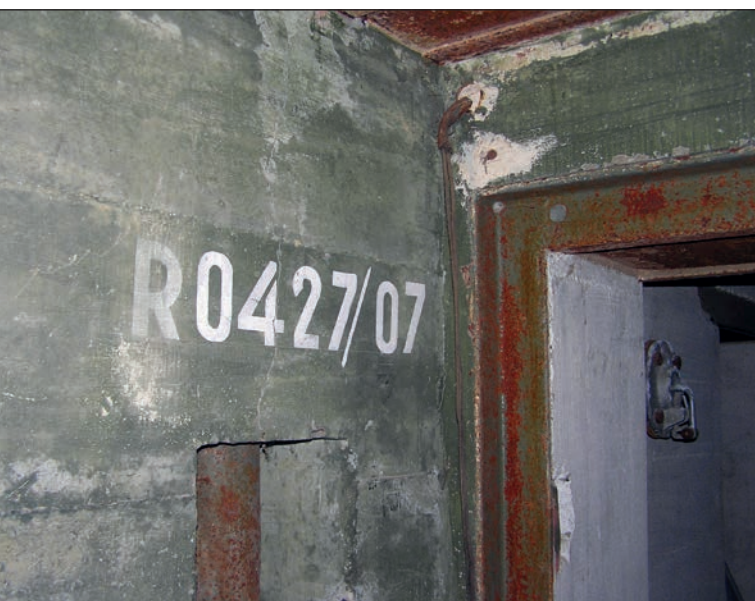
Figura 5. Código de un abrigo para personal en la posición Ro 427 , siendo la séptima construcción de la misma (fotografía de Jean-Luc Moser).
