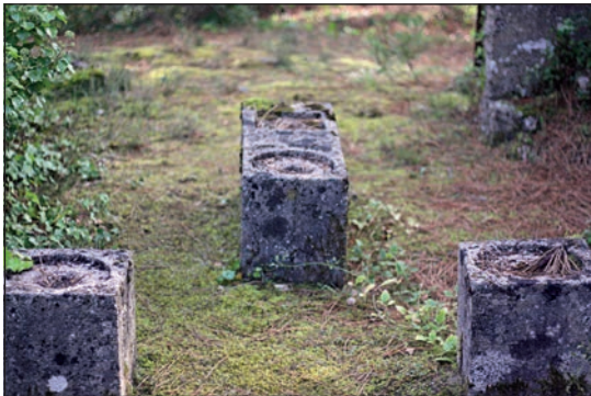
Figura 31. Restos de un asentamiento artillero para un cañón antiaéreo de 20 mm. 31a: Fotografía donde se aprecian las tres bases de hormigón para cada uno de los soportes que formaban la plataforma triangular de la pieza. Al estar sobre una base sobreelevada, los sirvientes podían atenderla más fácilmente y se cansaban menos cuando realizaban acciones de fuego sostenido. 31b: Detalle de uno de los bloques frontales, cuadrangulares, de treinta centímetros de lado, con la impresión de la base circular en el mismo (fotografías autor).
