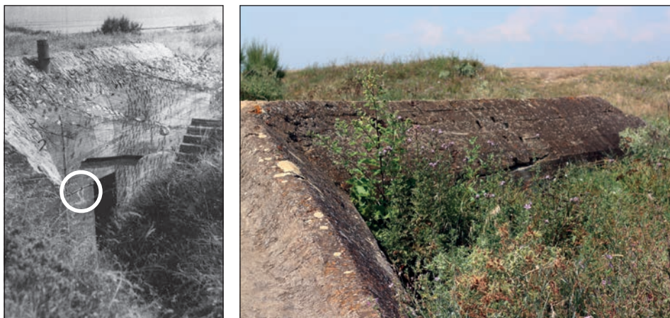
Figura 19. Imagen comparativa de uno de los abrigos de personal modelo 501 después de la guerra y en la actualidad. 19a: Fotografía que muestra el acceso a dicha construcción, son todavía visibles la escalera y el sencillo vierteaguas de chapa sobre la puerta; así, como el tubo de salida de la estufa situada en la habitación de personal. Resaltado con un círculo está la inscripción St , la cual indicaba que la estructura era a prueba de bombas ( Ständig ); excepcionalmente se pintaba sobre la entrada o cerca de ella, como en este caso. El texto se comenzó a utilizar a partir de mayo de 1944 y hacía referencia a las construcciones con techos y muros de un espesor mínimo de dos metros de hormigón armado (SHM Rochefort IW 1843). 19b: Una fotografía de la misma estructura en la actualidad. Se puede observar como los accesos a la misma están totalmente colmatados por tierra y vegetación (fotografía autor).
