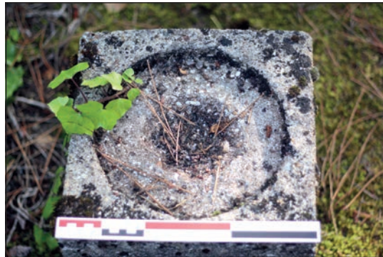
Figura 31. Restos de un asentamiento artillero para un cañón antiaéreo de 20 mm. 31a: Fotografía donde se aprecian las tres bases de hormigón para cada uno de los soportes que formaban la plataforma triangular de la pieza. Al estar sobre una base sobreelevada, los sirvientes podían atenderla más fácilmente y se cansaban menos cuando realizaban acciones de fuego sostenido. 31b: Detalle de uno de los bloques frontales, cuadrangulares, de treinta centímetros de lado, con la impresión de la base circular en el mismo (fotografías autor).
