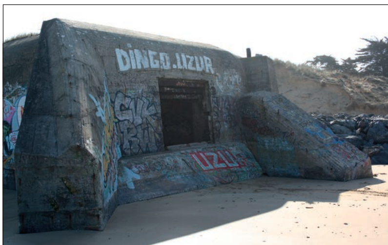
Figura 37. Vista de la misma construcción poco antes de ser demolida. Son visibles los muros de flanqueo que incrementaban la protección, pero limitaban el sector de tiro de la pieza (fotografía autor).
