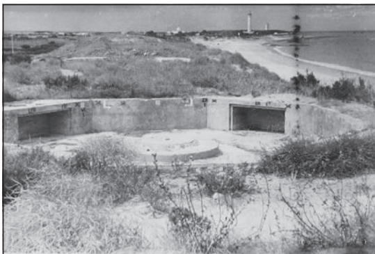
Figura 32. Imagen de una de las dos posiciones antiaéreas de Klara, de perfil exterior cuadrado y forma octogonal en el interior, con una plataforma de tiro circular. Al fondo se pueden ver los dos faros de la punta de Baleines (SHM Rochefort 1W 1849).
