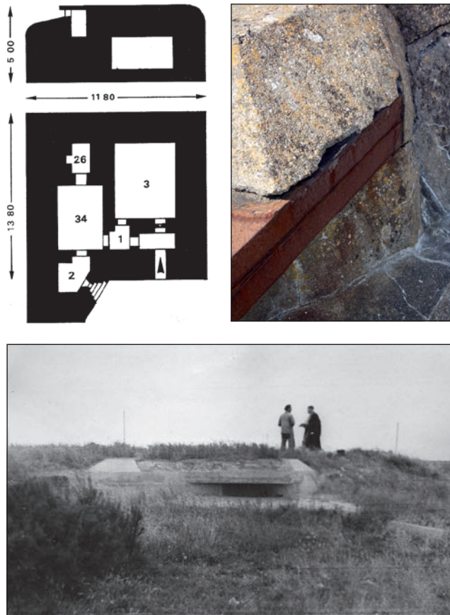
Figura 26. Imágenes del puesto de observación 627. 26a: plano de dicha construcción (Rudi Rolf). 26b: fotografía de Schwalbe al poco de finalizar el conflicto, donde se muestra en primer plano la zona de observación protegida por las placas blindadas (SHM Rochefort 1W 1849). 26c: Detalle de la protección blindada formada por la unión de dos placas de diez centímetros de espesor cada una, pertenecientes a la cercana batería de Saint-Denis (fotografía autor).
