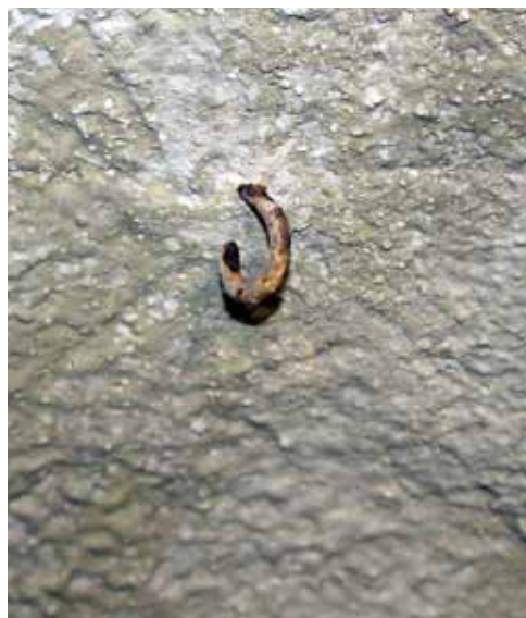
Figura 17. Gancho recurrente en los puestos de ametralladora o fusil ametrallador (subelemento 1 de La-solöa). Fuente: Pablo Orduna Portús.
