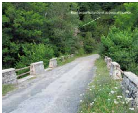
Figura 16. Posicionamiento estratégico de búnker (Onzibieta). Fuente: Pablo Orduna Portús.
