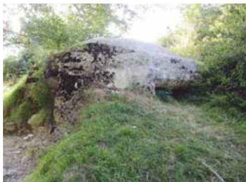
Figura 19. Exterior de bunker para fusil ametrallador (Belaibarra). Fuente: Pablo Orduna Portús.
