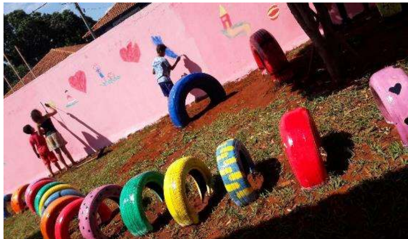
Figura 4 - Construção do parquinho com pneus usados
